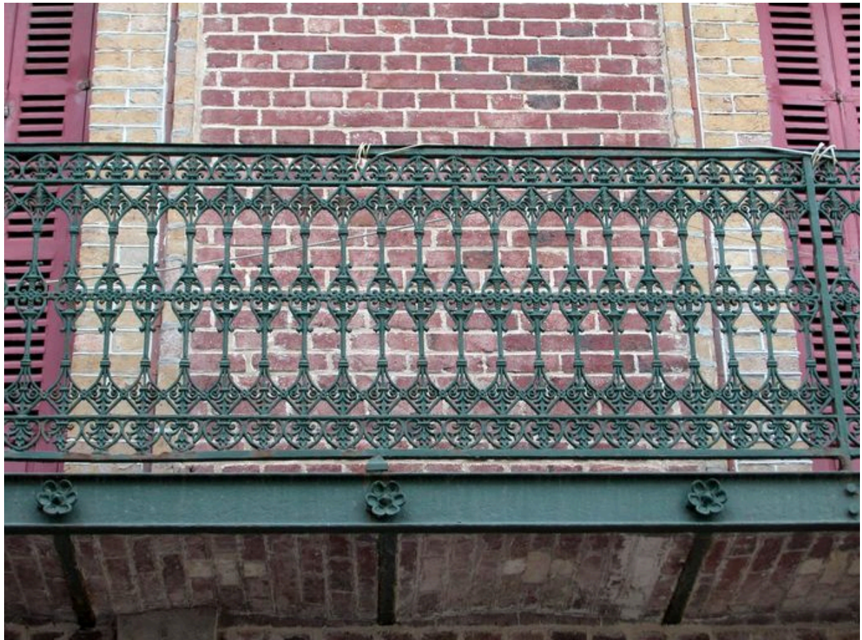
Détail d'un garde-corps en fonderie.
