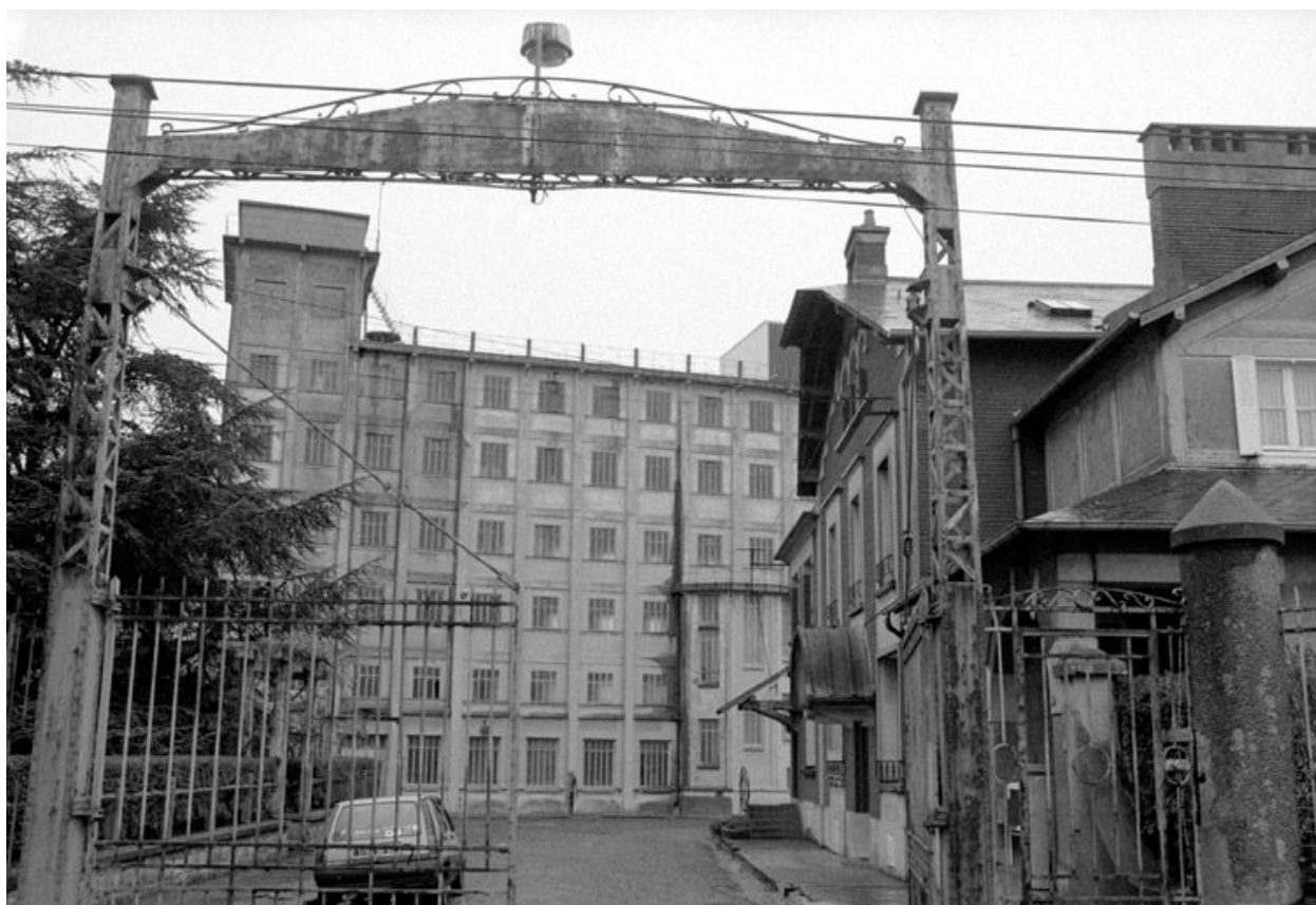
Façade sur rue de la minoterie en 1990.
