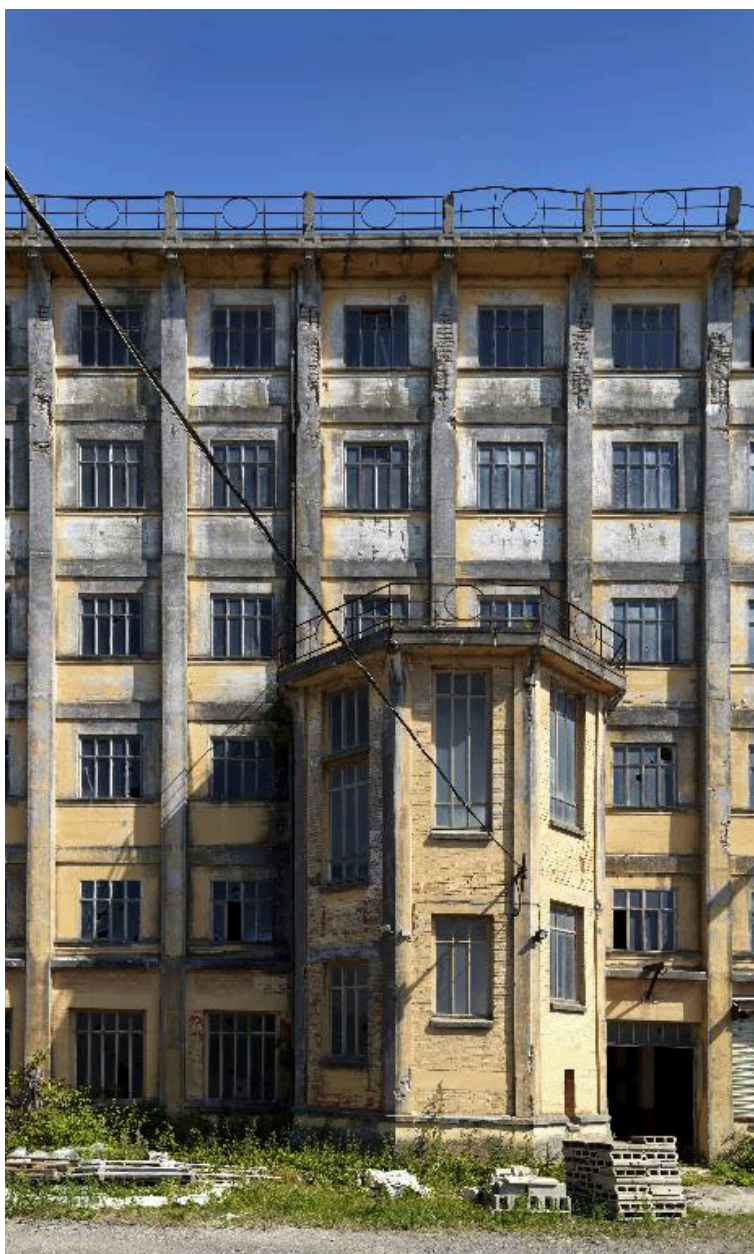
Détail de l'avant-corps semi-hexagonal de la minoterie.
