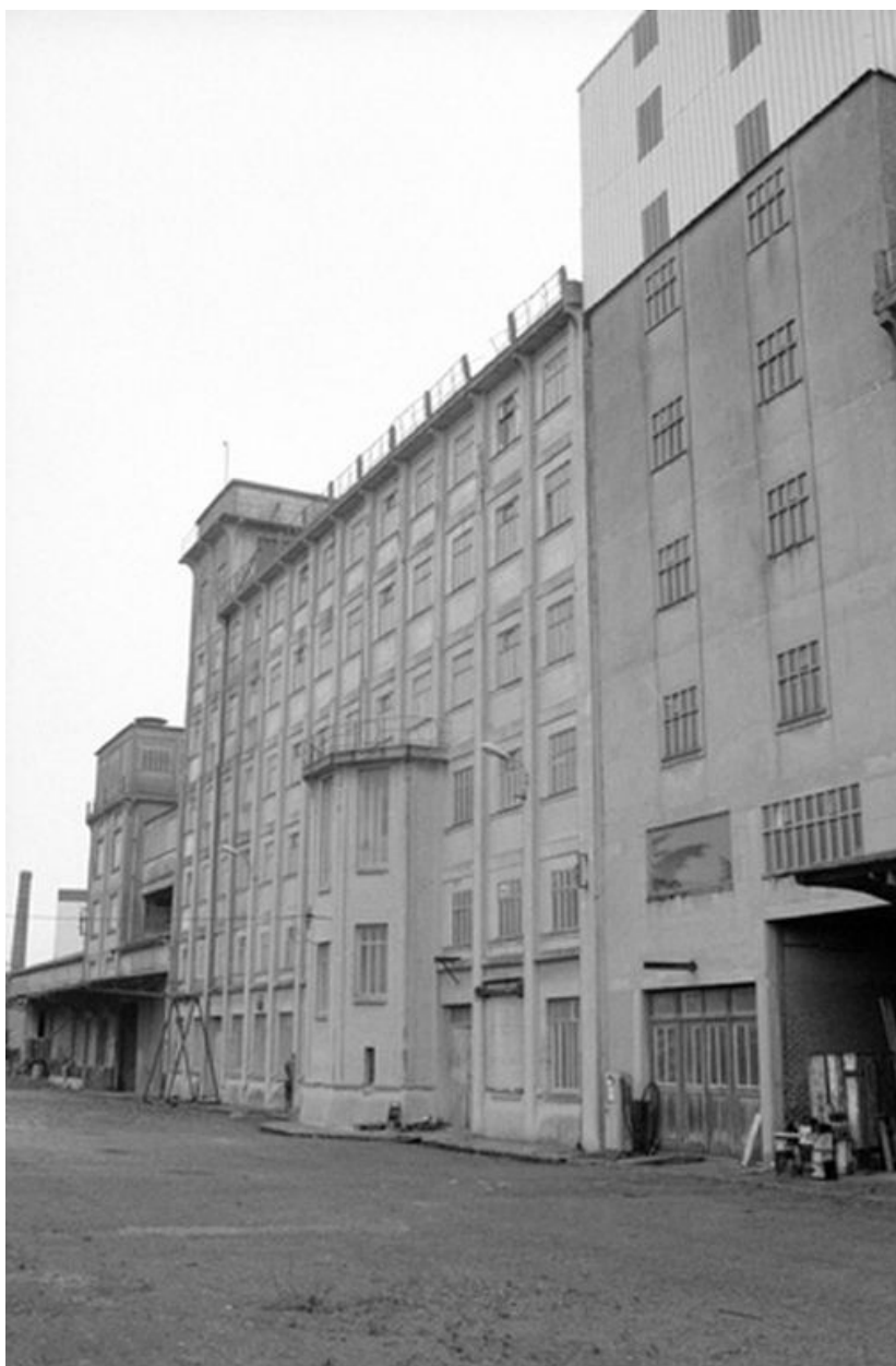
Vue d'ensemble sud-est de la minoterie en 1990.
