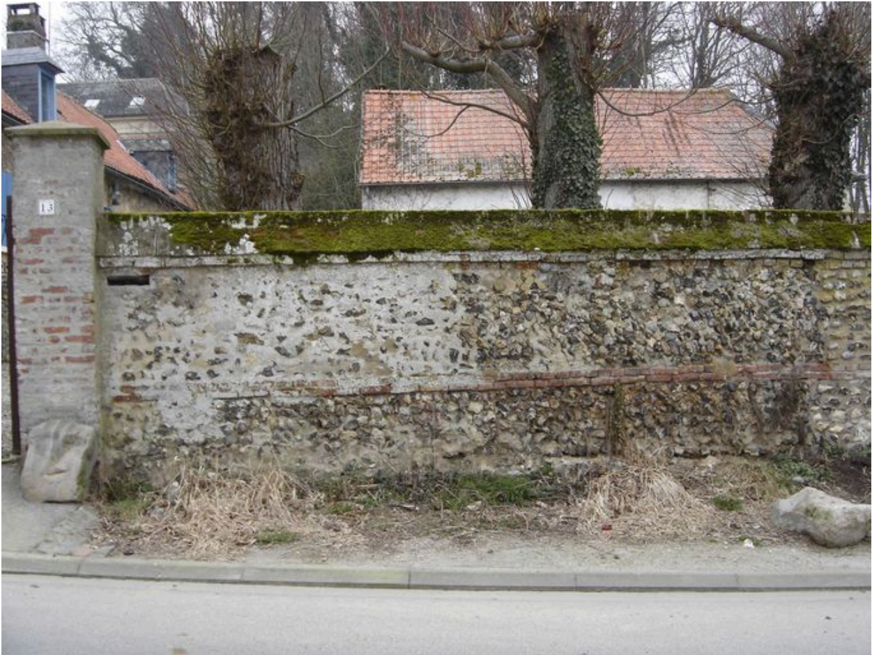
Vue partielle du mur de clôture.
