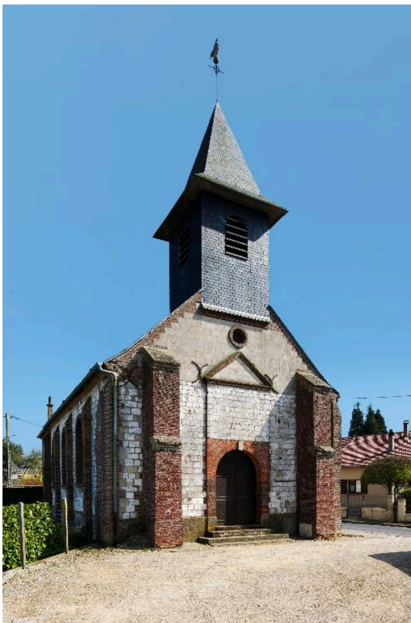
Vue générale depuis nord-ouest
