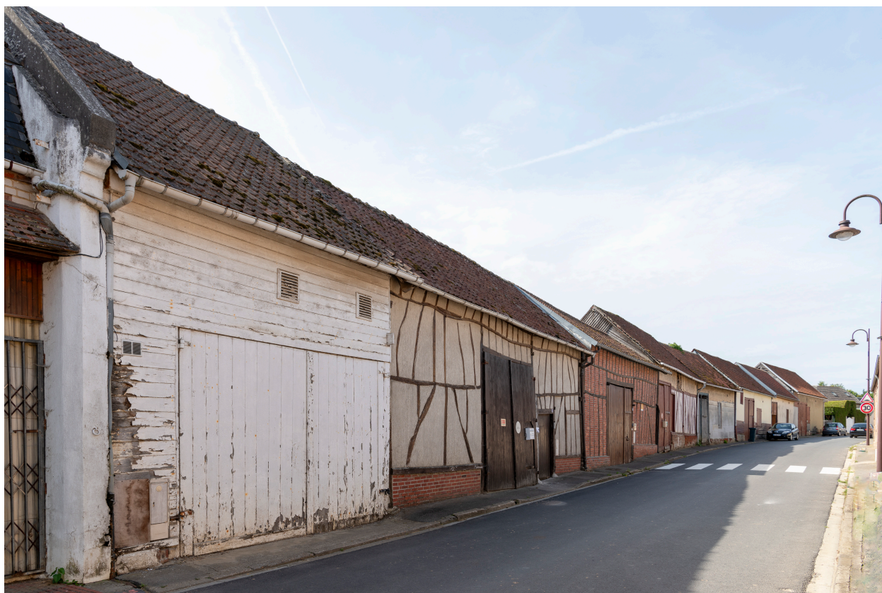
Alignement de granges sur la rue Roland-Mariage, vue prise depuis l'est.
