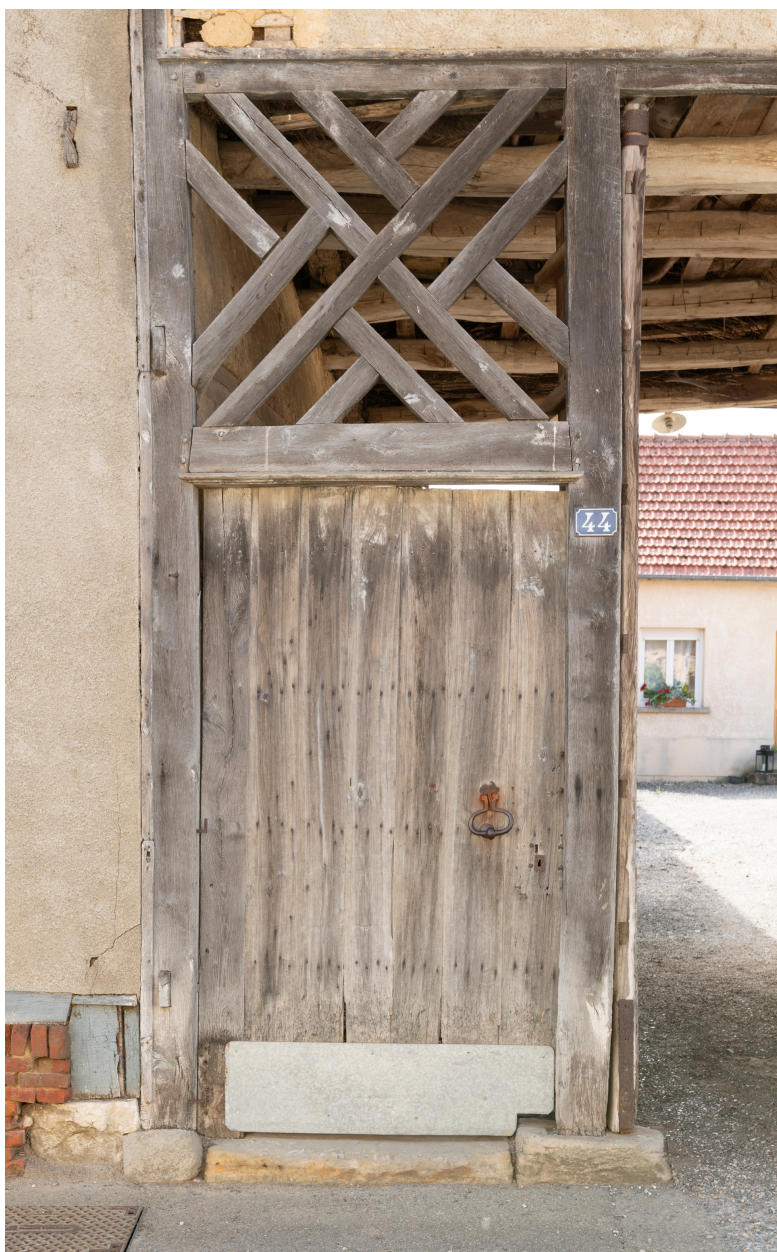
Porte piétonne avec imposte ajourée, n°44 de la rue Roland-Mariage, vue prise depuis le nord.
