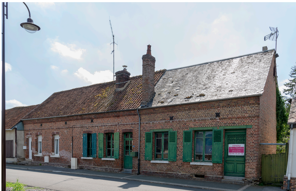
Anciens logements d'ouvriers, n°24-26, rue de l'École, vue prise depuis le nord-est.
