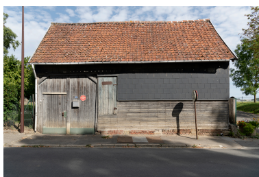
Grange sur rue, n°59 de la rue Roland-Mariage, vue prise depuis le nord. Phot. Marc Kérignard IVR32_20236000889NUCA
