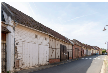
Alignement de granges sur la rue Roland-Mariage, vue prise depuis l'est. Phot. Marc Kérignard IVR32_20236000884NUCA
