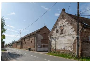
Ferme à cour, n°27 de la rue du Petit Paris, vue prise depuis le nord. Phot. Marc Kérignard IVR32_20236000898NUCA
