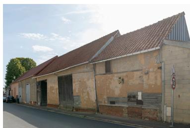
Alignement de granges sur la rue Roland-Mariage, vue prise depuis le nord. Phot. Marc Kérignard IVR32_20236000882NUCA
