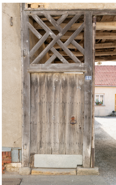
Porte piétonne avec imposte ajourée, n°44 de la rue Roland-Mariage, vue prise depuis le nord. Phot. Marc Kérignard IVR32_20236000881NUCA
