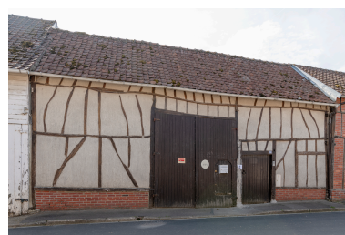
Grange sur rue, n°34 de la rue Roland-Mariage, vue prise depuis le nord. Phot. Marc Kérignard IVR32_20236000883NUCA
