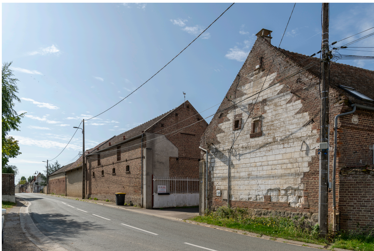
Ferme à cour, n°27 de la rue du Petit Paris, vue prise depuis le nord.
