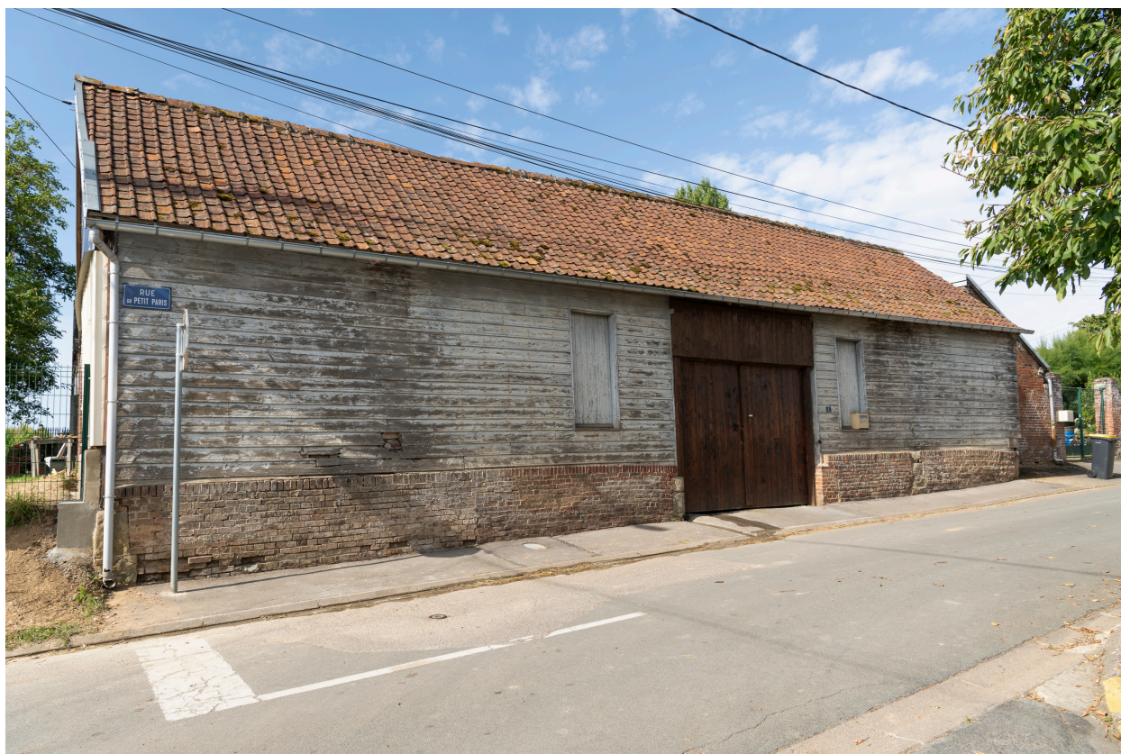
Grange sur rue avec portes à engranger, n°1 de la rue du Petit Paris, vue prise depuis le nord.
