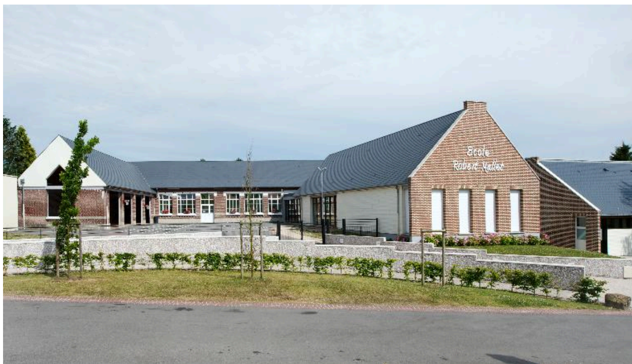
Vue d'ensemble sur rue.
