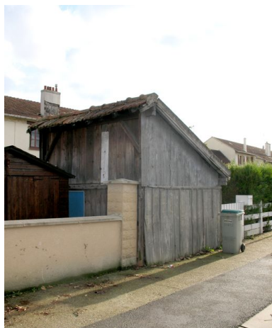
Appentis en bois (abri de jardin) construit au début des années 1920. Phot. Clarisse Lorieux IVR22_20096005199NUCA
