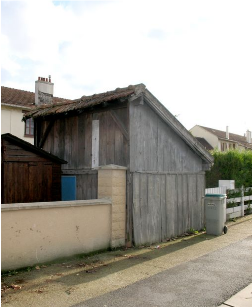
Appentis en bois (abri de jardin) construit au début des années 1920.
