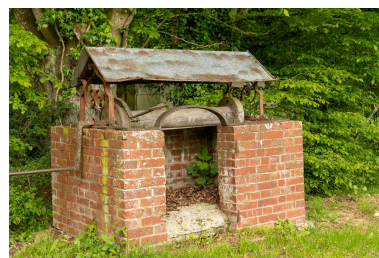
Puits de Petit Froissy, sur la placette. Phot. Marc Kérignard IVR32_20236000715NUCA
