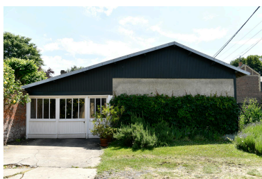
Baraquement provisoire du magasin Hua, vue depuis l'ouest. Phot. Marc Kérignard IVR32_20226000493NUCA
