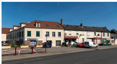
Commerces dont l'ancien Café de la Gare, n°5-13 rue de Provinlieu, vue depuis le sud-est. Phot. Marc Kérignard IVR32_20236000723NUCA
