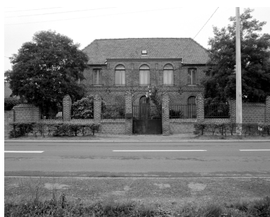
Vue générale de face. Phot. Philippe Dapvril IVR31_20045900480X
