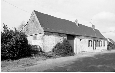
Vue d'ensemble depuis le sud. Phot. Christiane Riboulleau IVR22_19900202740Z
