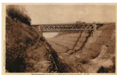
Deux ponts métalliques mis en place sur la grande tranchée d'Havrincourt pour rétablir la circulation après guerre. Les berges restent endommagées. Carte postale, vers 1918-1920 (?). Repro. Pierre Thibaut IVR32_20226200279NUCAB
