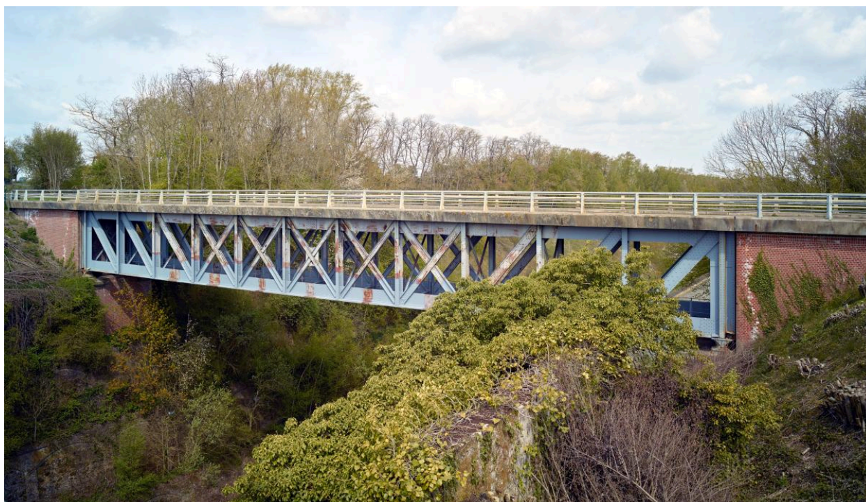
Pont routier nord.
