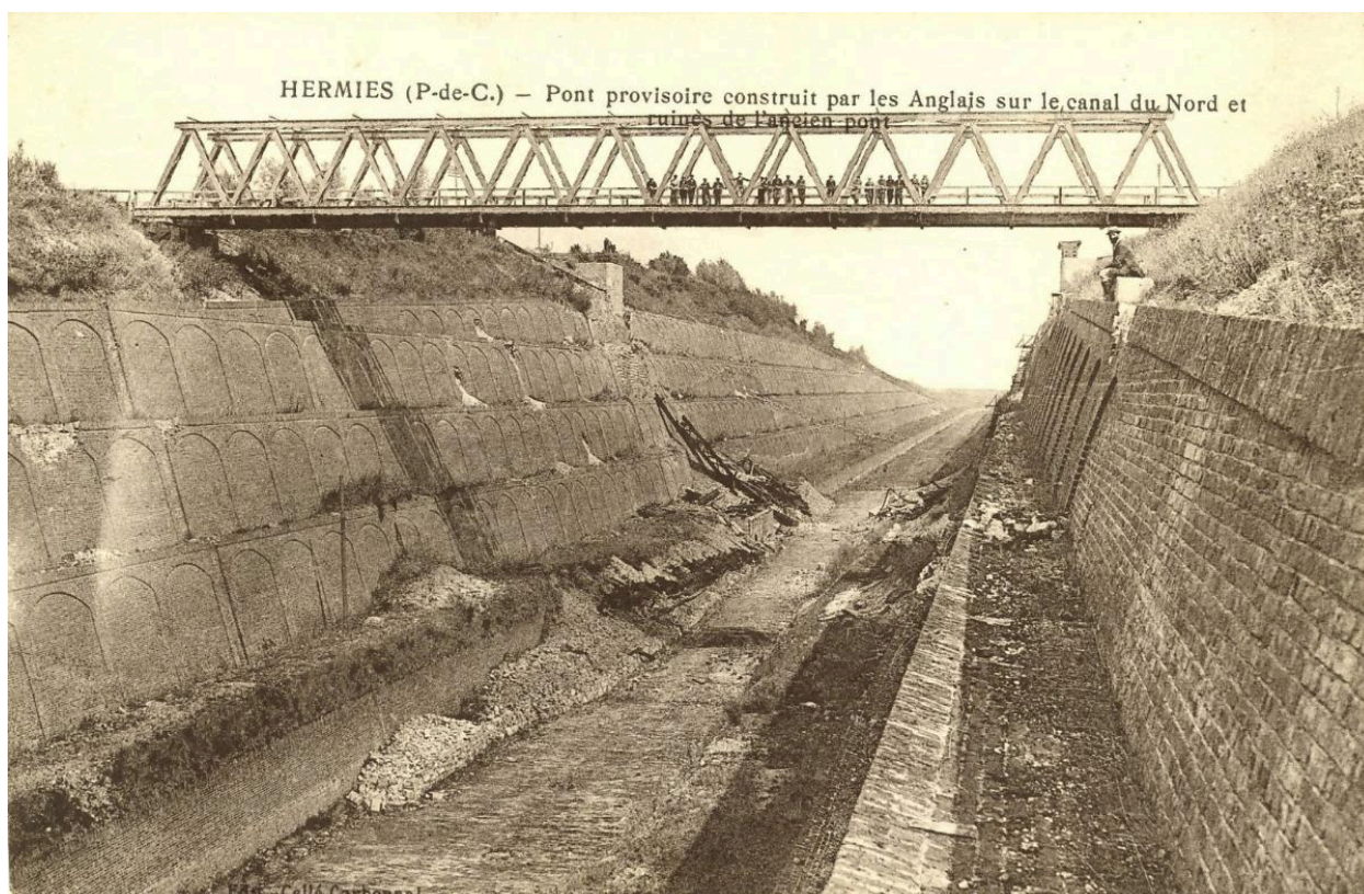
Pont provisoire installé par les troupes du Génie britannique pour rétablir la circulation sur la grande tranchée d'Havrincourt. Carte postale, vers 1918 (?).
