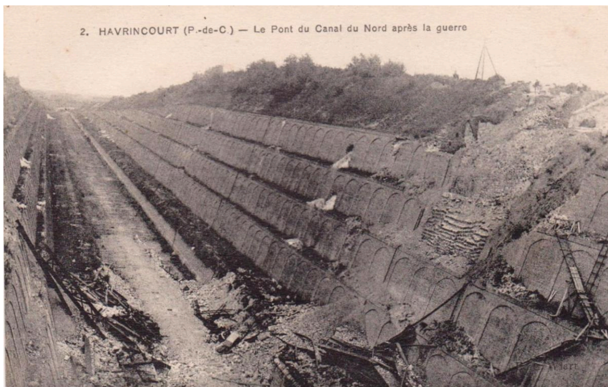
État de la grande tranchée d'Havrincourt après la Première Guerre mondiale. Destruction des ponts et d'une partie des berges maçonnées. Cuvette partiellement comblée. Carte postale, après 1918.
