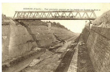
Pont provisoire installé par les troupes du Génie britannique pour rétablir la circulation sur la grande tranchée d'Havrincourt. Carte postale, vers 1918 (?). Repro. Pierre Thibaut IVR32_20226200281NUCAB
