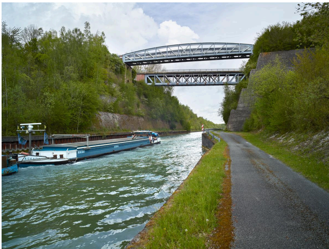
Vue depuis le sud de l'ouvrage.
