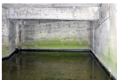
La soute à munition Phot. Pierre Thibaut IVR31_20155901177NUCA
