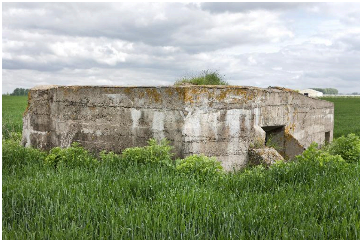
Vue vers le nord-est.
