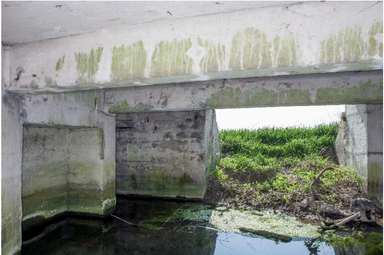
Vue intérieure de la chambre de tir, vers l'arrière. A gauche, l'accès à la soute à munitions
