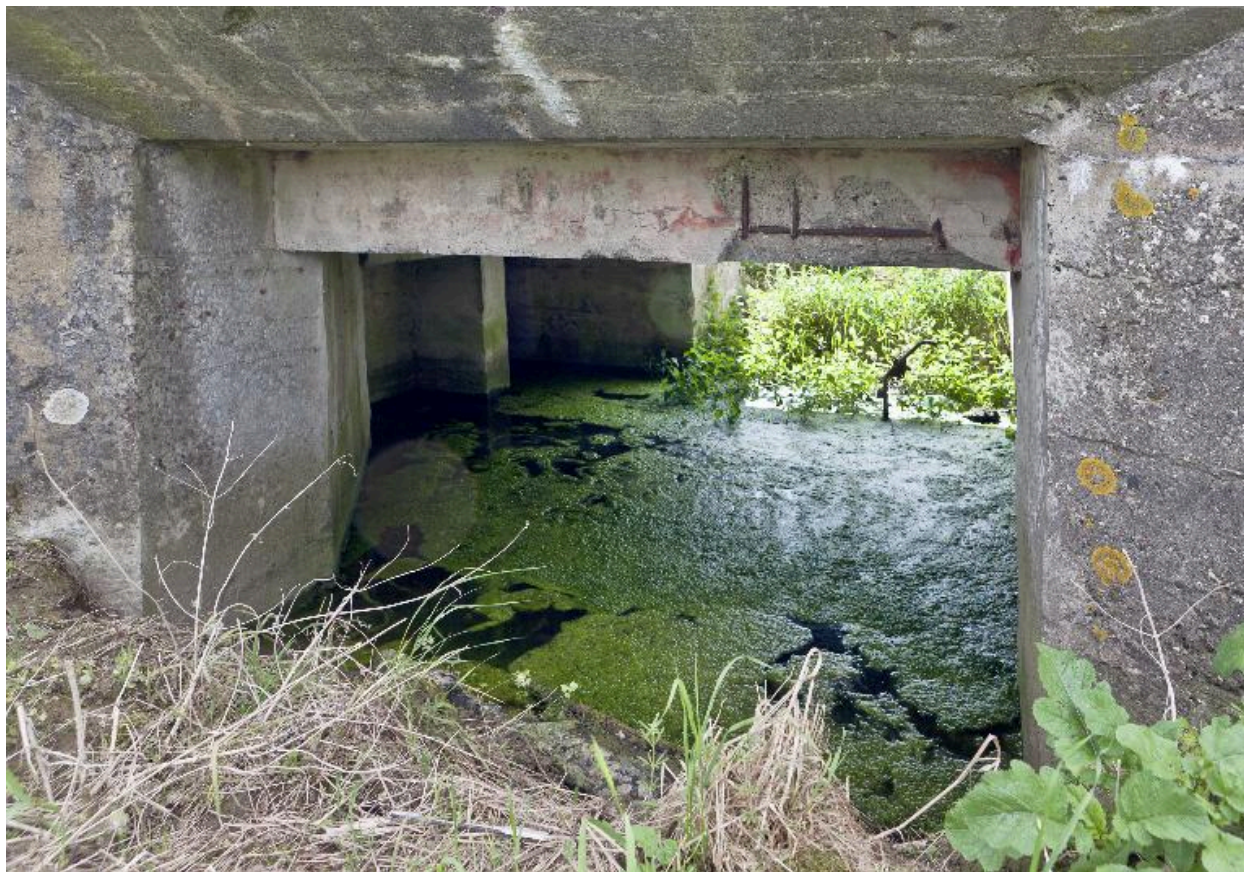
Sortie de la chambre de tir
