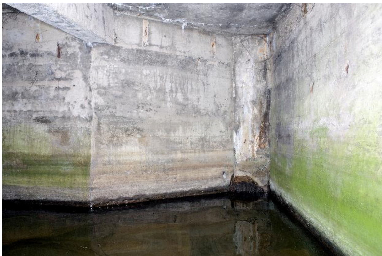
Mur externe de la chambre de tir, depuis la soute à munitions
