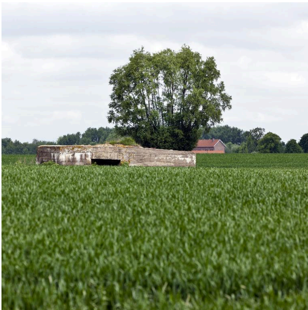
Elévation antérieure, vers le nord-ouest
