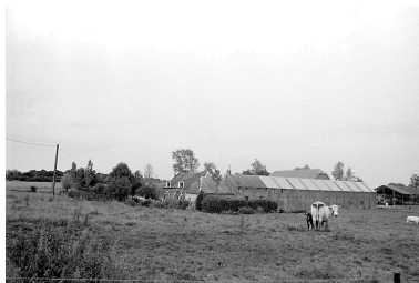
Vue générale depuis le sud-ouest. Phot. Xavier-Philippe Guiochon IVR22_19980201507Z
