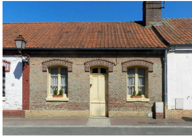
Vue de la façade d'un des logements de la cité. Phot. Romain Grimaud IVR22_20128005218NUC1A
