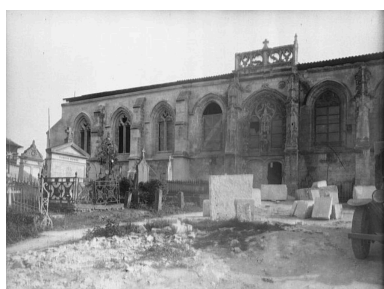
Chantier de restauration de l'église de Fontaine-sur-Somme, 1950 (Charenton-le-Pont, médiathèque de l'architecture et du patrimoine ; AP02L04153). Repro. Médiathèque de l'architecture et du du Patrimoine IVR32_20238005223NUCA
