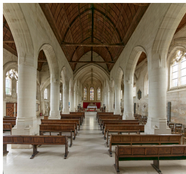
Intérieur, vue de la nef et du chœur depuis le clocher. Phot. Thierry Lefébure IVR32_20238000346NUCA
