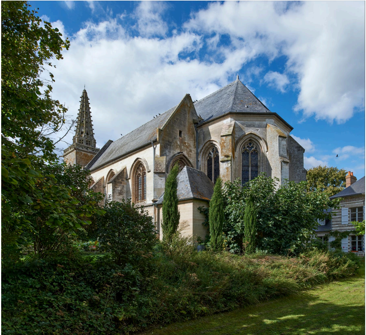
Vue sud-ouest du chevet, de la chapelle Saint-Joseph et de la sacristie.
