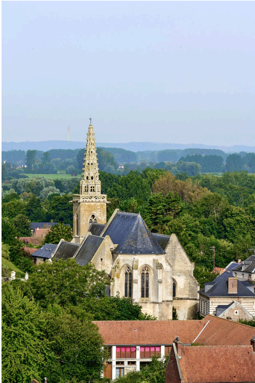
Vue est de l'église prise depuis le chemin Neuf.
