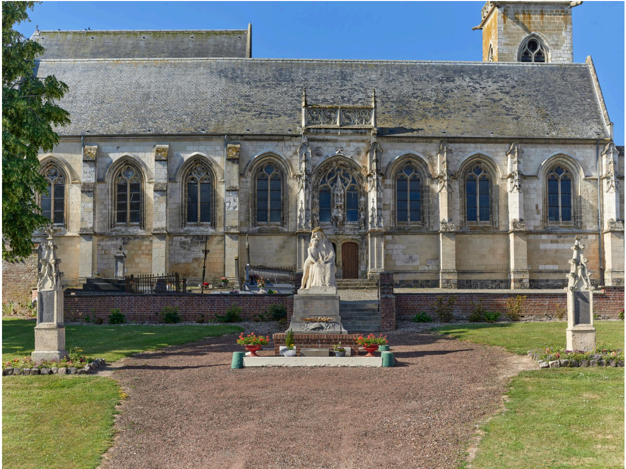
Vue nord de la nef et de la chapelle de la Vierge.
