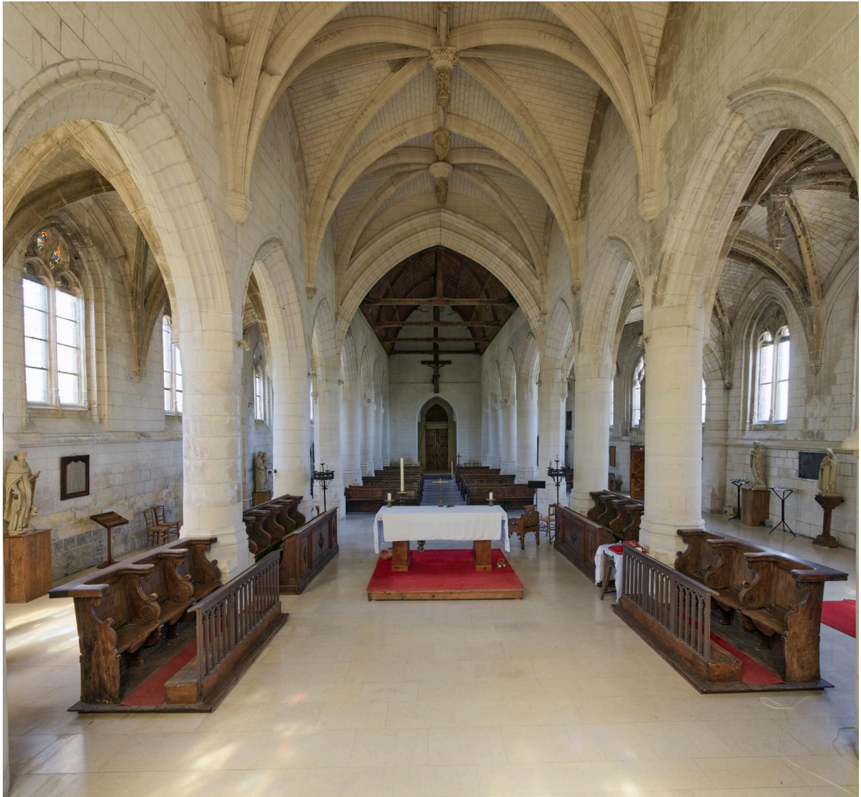
Vue intérieure vers la nef à l'ouest.
