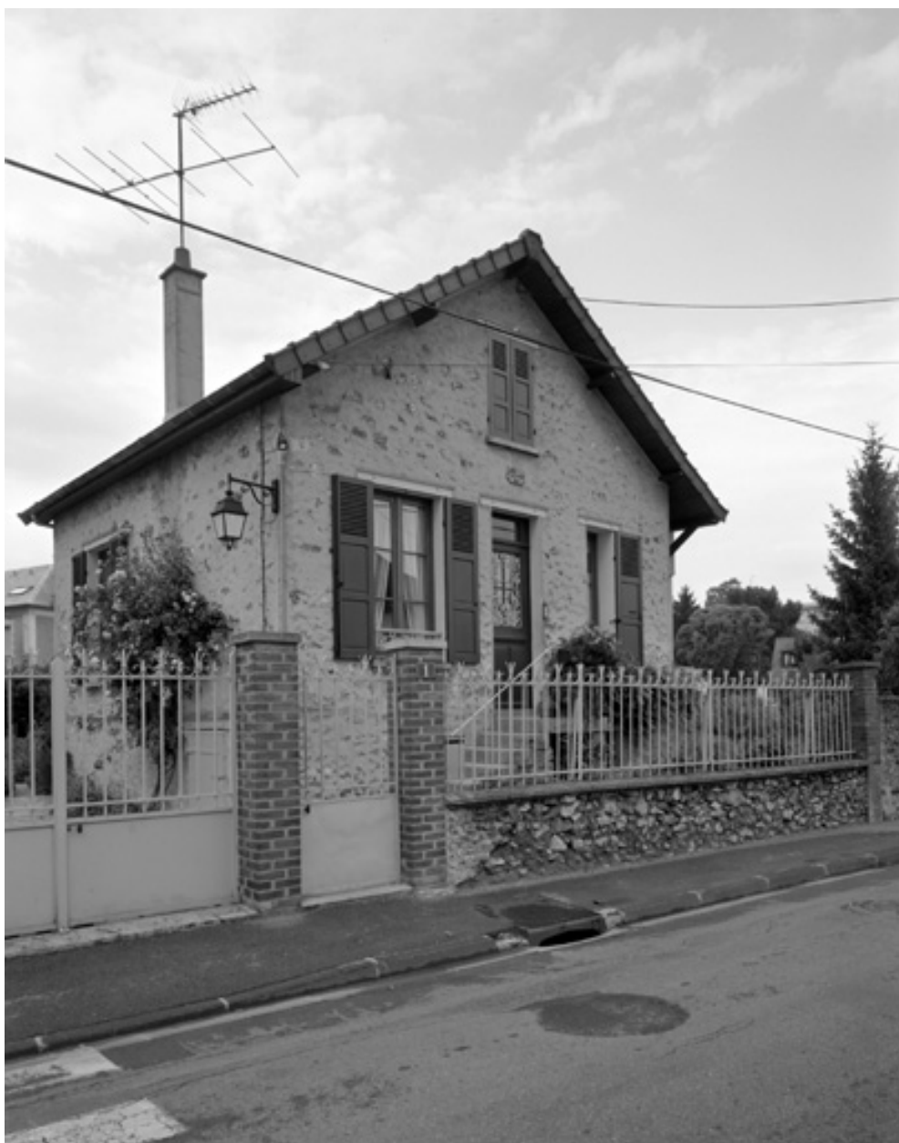
Vue de la façade sur la rue.
