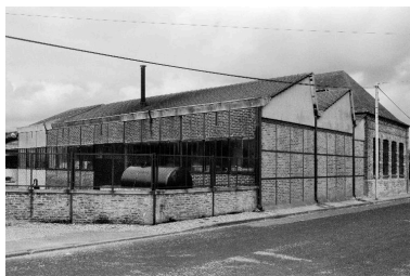
Atelier de fabrication, flanc sud-est. Phot. Benoît Dufournier IVR22_19888001118Z
