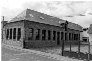
Atelier de fabrication, flanc nord. Phot. Benoît Dufournier IVR22_19888001120Z
