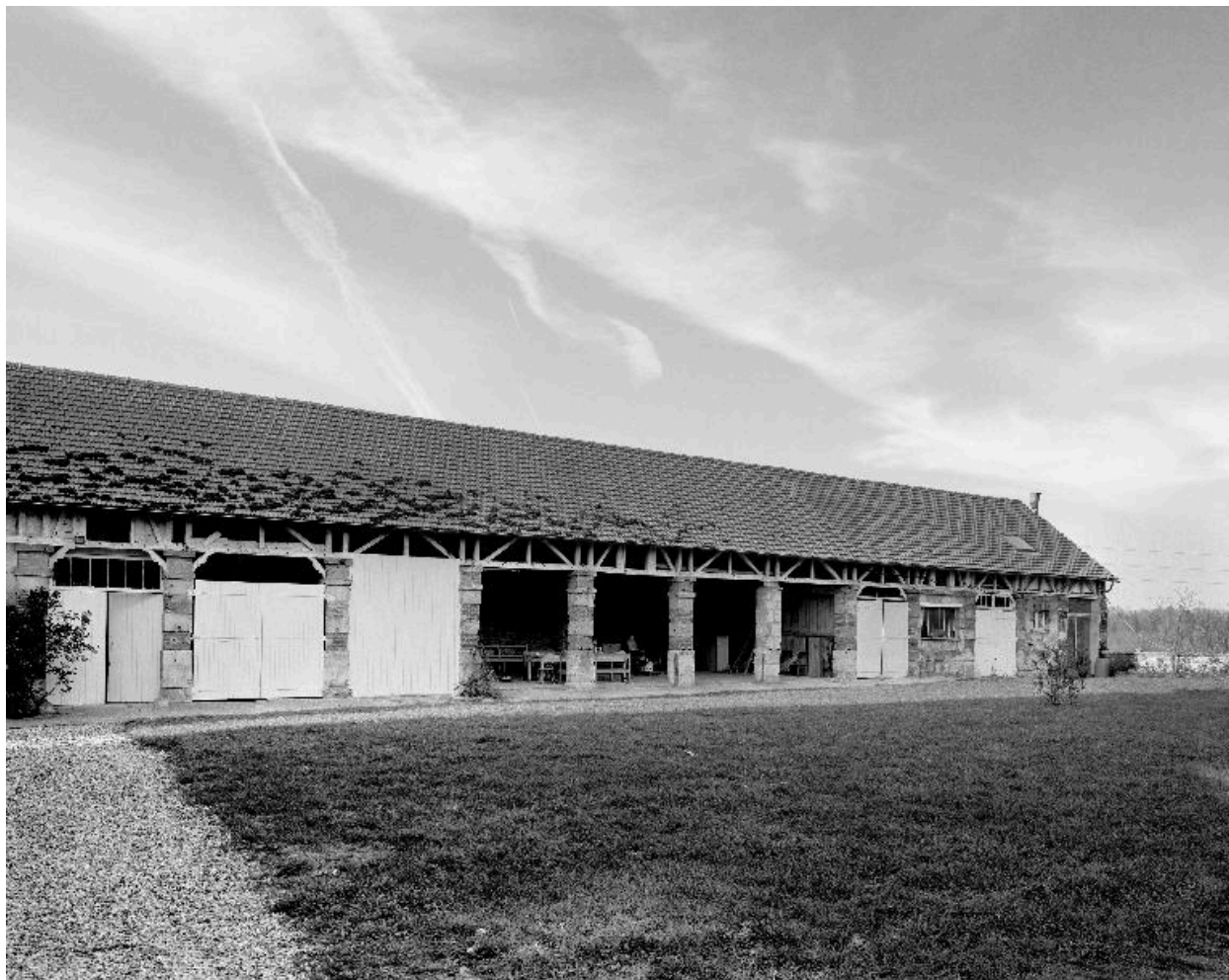
Élévation sur cour des remises.
