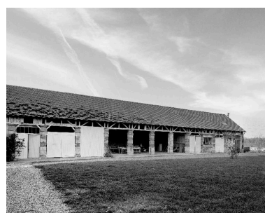
Élévation sur cour des remises. Phot. Thierry Lefébure IVR22_19900200641V
