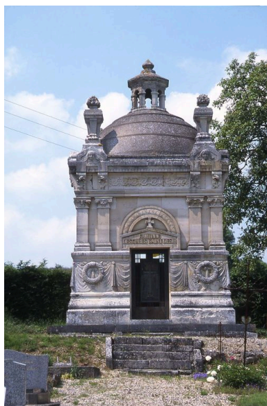
Vue du monument de la famille Descubes Saint-Désir. Phot. Inès Guérin IVR22_20030202891NUCA
