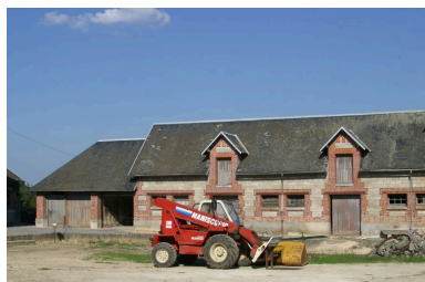
Vue de l'écurie située dans le prolongement du pigeonnier Phot. Inès Guérin IVR22_20050200884NUCA
