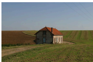
Vue de la maison ouvrière isolée. Phot. Inès Guérin IVR22_20050200887NUCA
