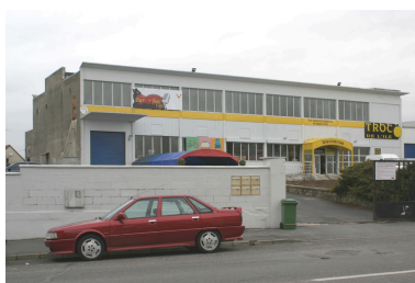
Façade antérieure des ateliers de 1950.
