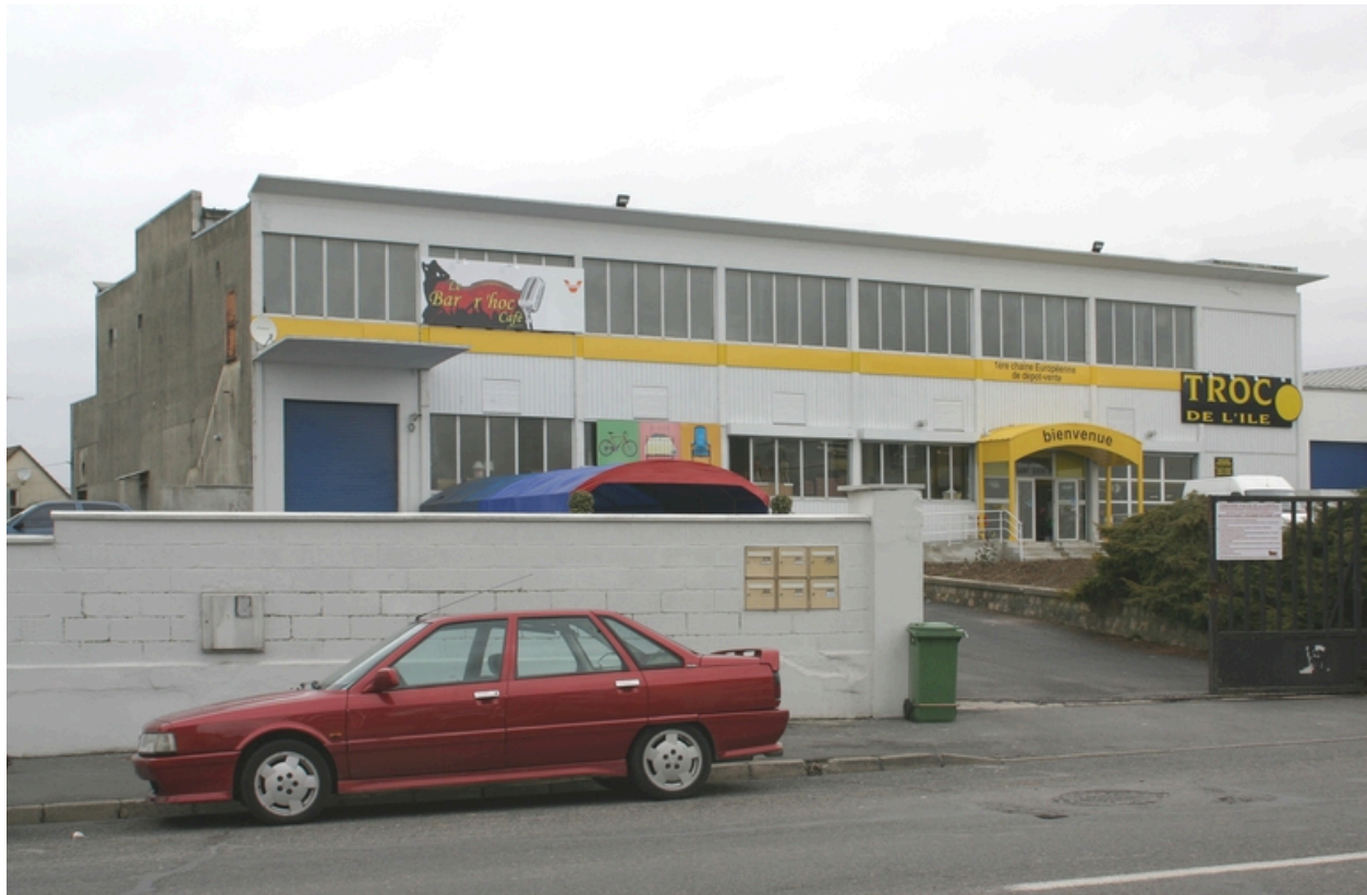
Façade antérieure des ateliers de 1950.
