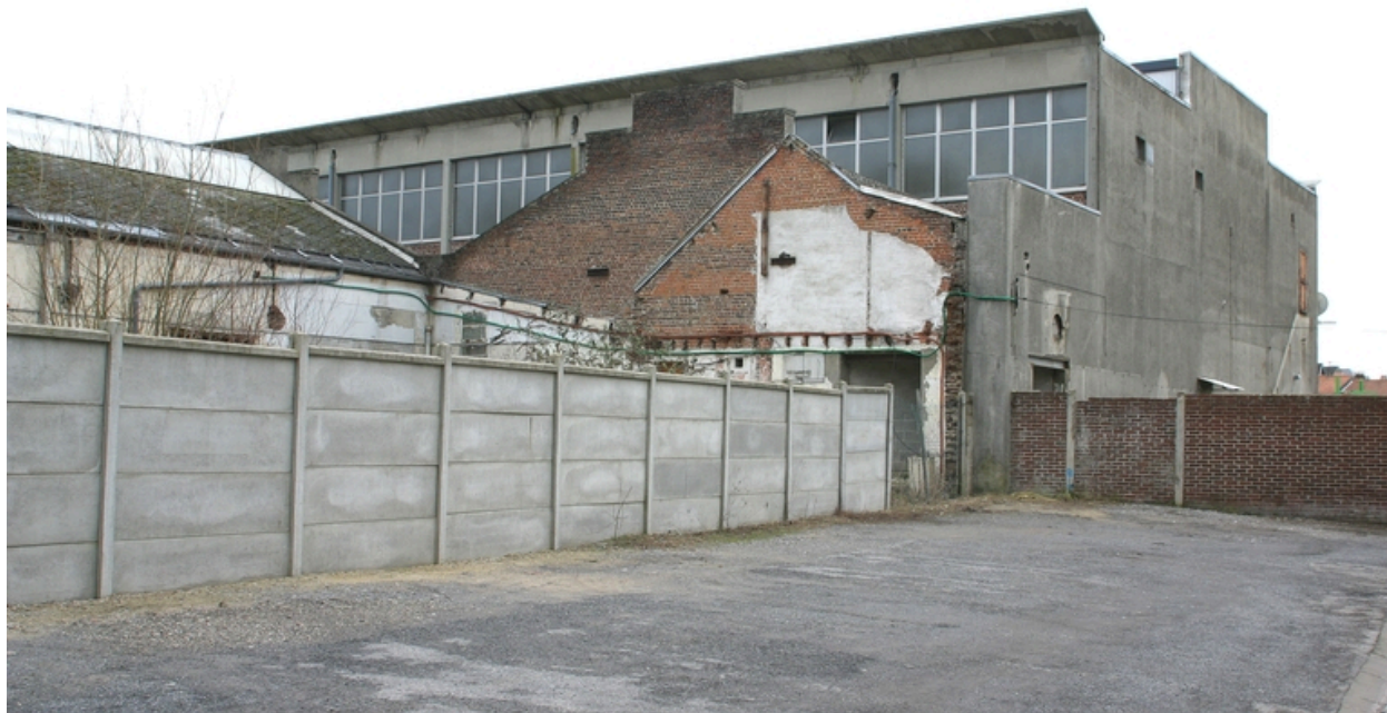
Façade postérieure des ateliers de 1950.
