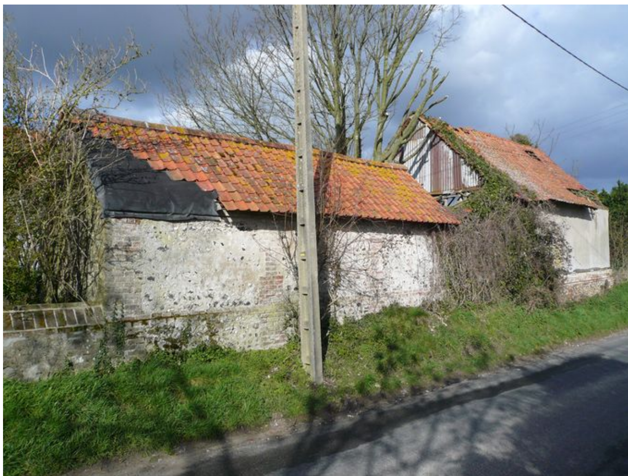
Vue des bâtiments sur rue.
