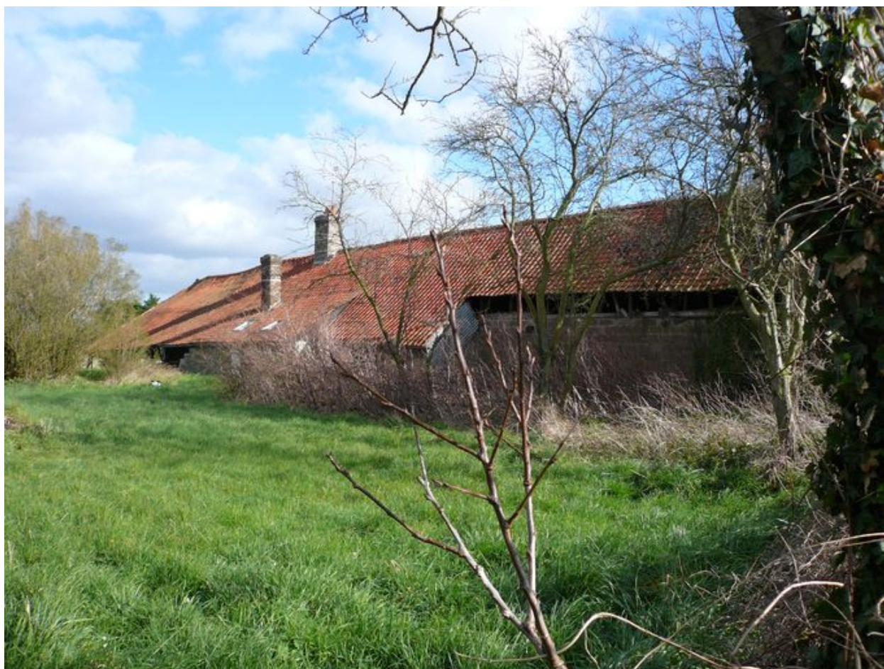
Vue postérieure du logis.
