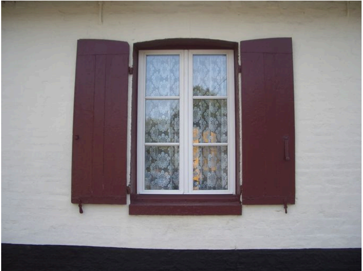
Vue détaillée d'un autre contrevent.
