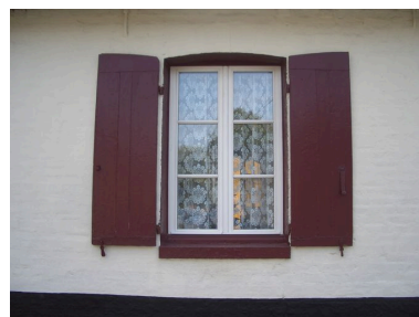
Vue détaillée d'un autre contrevent. Phot. Inès Guérin IVR22_20078005224NUCA
