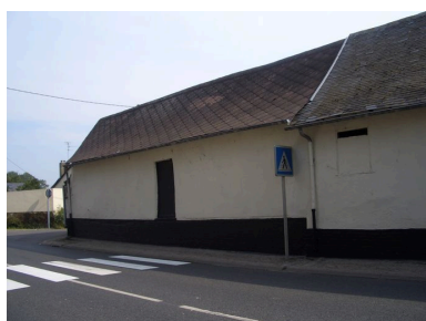
Vue de la grange dans le prolongement du logis et de l'écurie. Phot. Inès Guérin IVR22_20078005225NUCA
