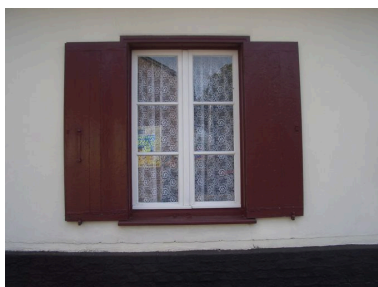
Vue détaillée d'un contrevent. Phot. Inès Guérin IVR22_20078005223NUCA
