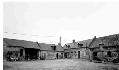
Vue des bâtiments sur cour. Phot. Jean-Michel Perrin IVR22_19856000836V
