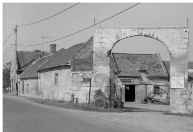
Vue générale depuis la rue. Phot. Jean-Michel Perrin IVR22_19856000899X
