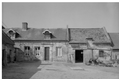
Logis. Elévation antérieure. Phot. Jean-Michel Perrin IVR22_19856000857X
