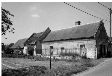
Logis. Elévation postérieure. Phot. Jean-Michel Perrin IVR22_19856000887X
