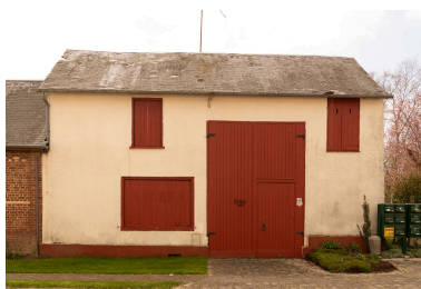
Logis sur rue avec boutique d'artisan et entrée charretière, n°44 de la Neuve-Rue, vue prise depuis le nord. Phot. Marc Kérignard IVR32_20236000299NUCA
