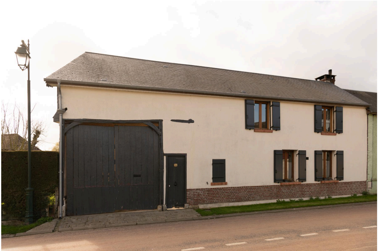
Logis sur rue avec entrée charretière, n°14 de la Neuve-Rue, vue prise depuis le nord.
