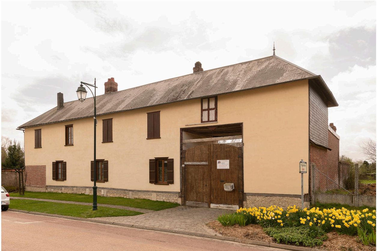
Logis sur rue avec entrée charretière, n°46 de la Neuve-Rue, vue prise depuis le nord.
