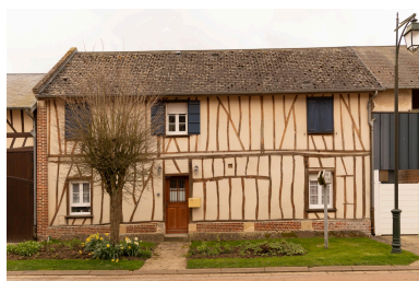
Logis sur rue, n°34 de la Neuve-Rue, vue prise depuis le nord.
