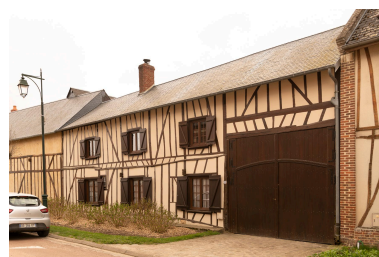
Logis sur rue avec entrée charretière, n°32 de la Neuve-Rue, vue prise depuis le nord.
