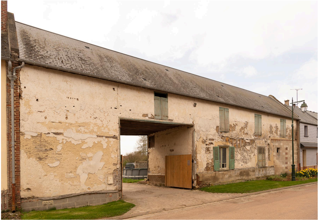
Logis sur rue avec entrée charretière et grange, n°34 de la Neuve-Rue, vue prise depuis le nord.
