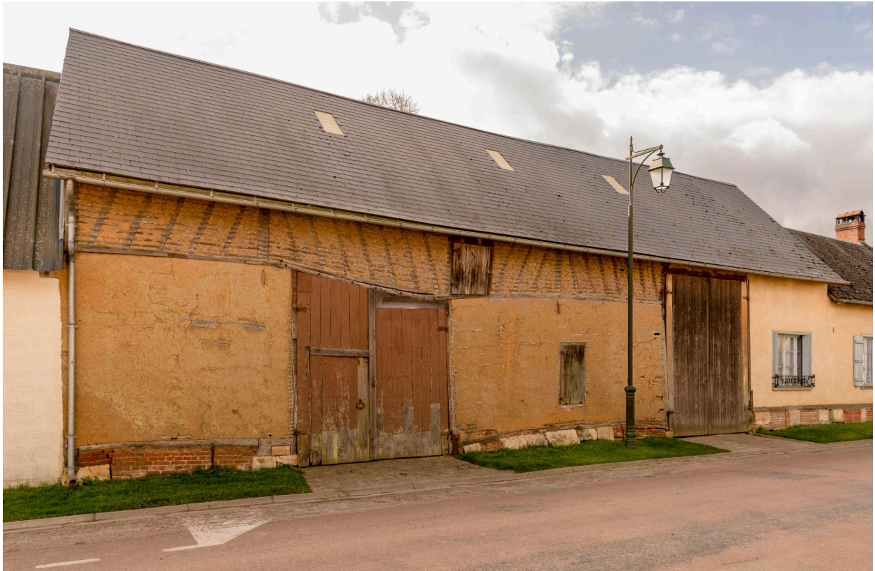
Grange sur rue n°8 de la Neuve-Rue, vue prise depuis le nord.
