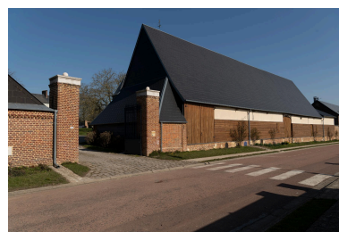
Grange sur rue de la ferme de la Neuve Rue (voir dossier), n°45 de la Neuve-Rue, vue prise depuis le sud. Phot. Marc Kérignard IVR32_20236000176NUCA
