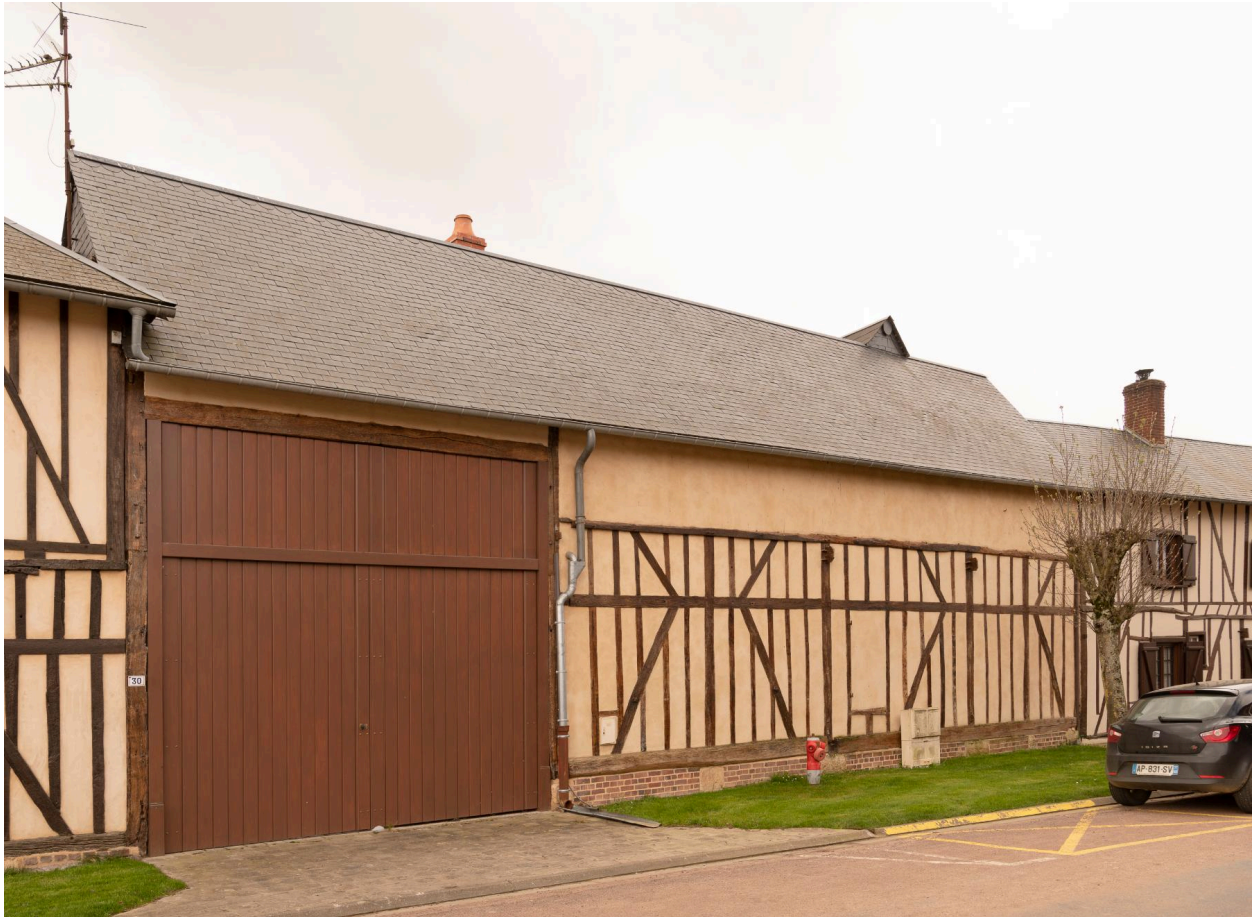
Grange sur rue, n°30 de la Neuve-Rue, vue prise depuis le nord.
