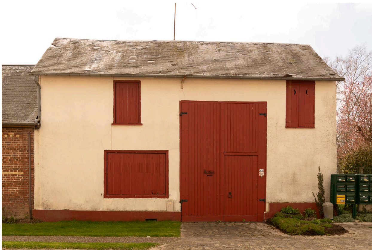
Logis sur rue avec boutique d'artisan et entrée charretière, n°44 de la Neuve-Rue, vue prise depuis le nord.
