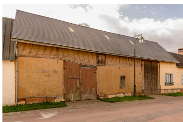
Grange sur rue n°8 de la Neuve-Rue, vue prise depuis le nord.
