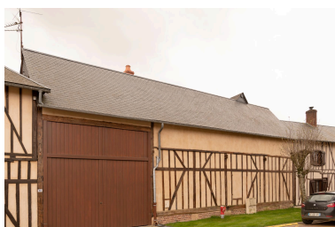
Grange sur rue, n°30 de la Neuve-Rue, vue prise depuis le nord.
