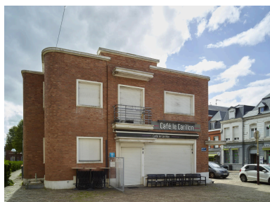
Extrémité nord/est du rang. Vue de face. Phot. Pierre Thibaut IVR32_20255900748NUCA
