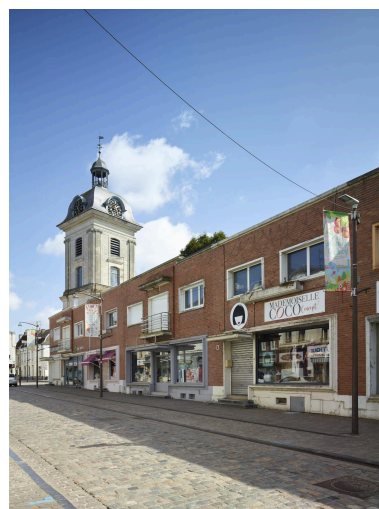
Vue d'ensemble du rang, côté façades avant. Vue orientée sud-ouest/nord-est. Phot. Pierre Thibaut IVR32_20255900148NUCA
