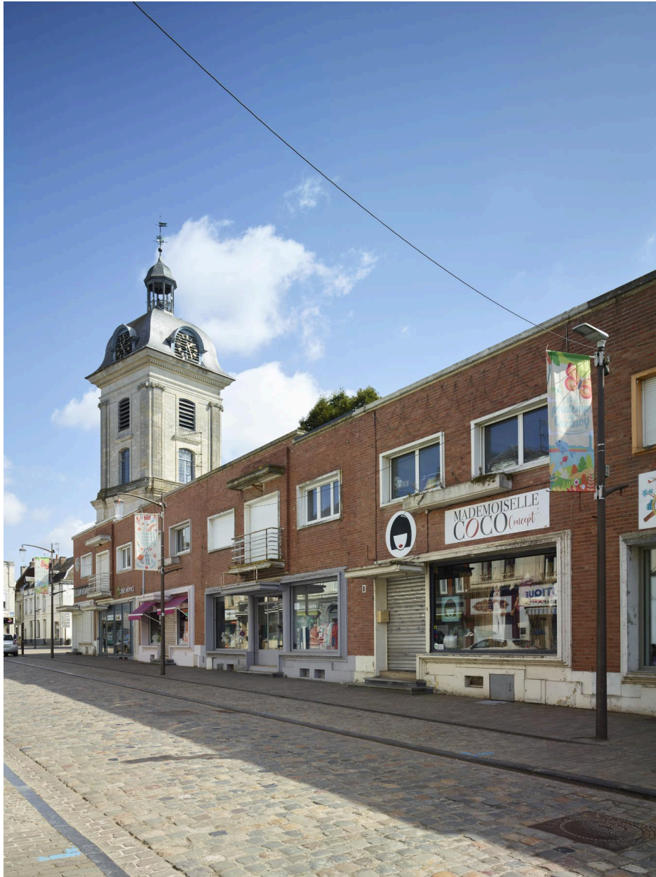
Vue d'ensemble du rang, côté façades avant. Vue orientée sud-ouest/nord-est.
