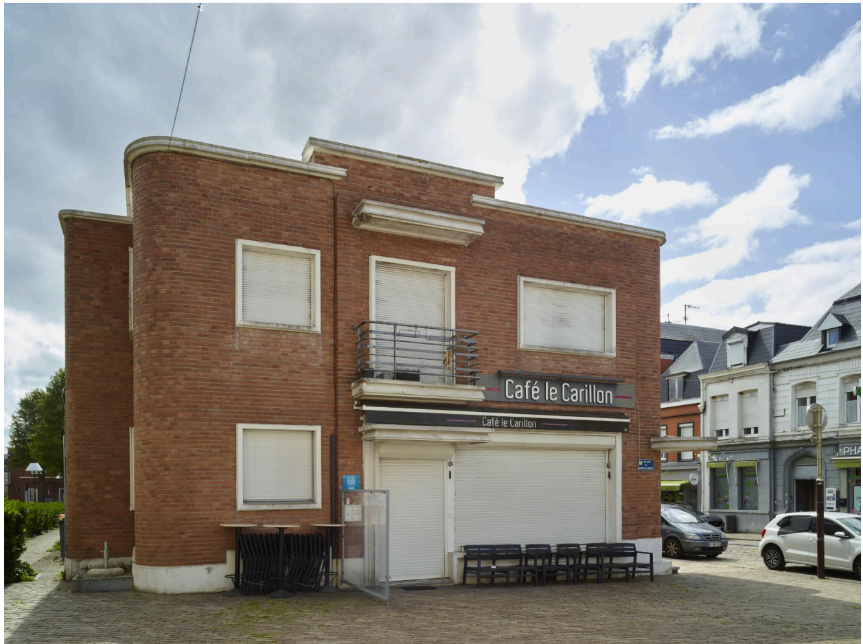
Extrémité nord/est du rang. Vue de face.
