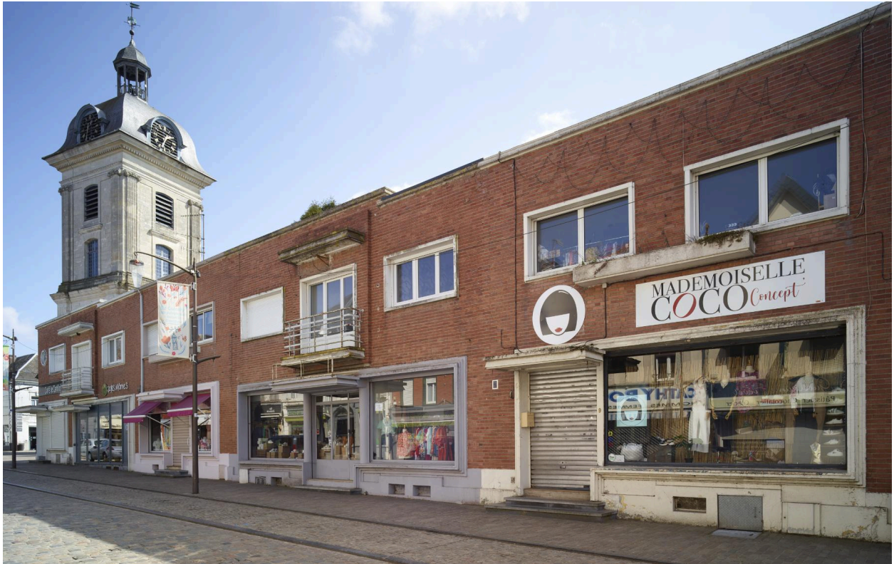
Vue générale des façades avant du rang. Vue orientée sud-ouest/nord-est.
