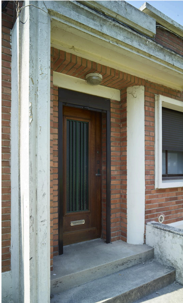
Détail de la porte sur la façade arrière correspondant au n°13 de la rue Fournier avec son huisserie d'origine.
