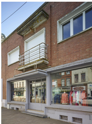
Détail de la façade n°7. Phot. Pierre Thibaut IVR32_20255900150NUCA
