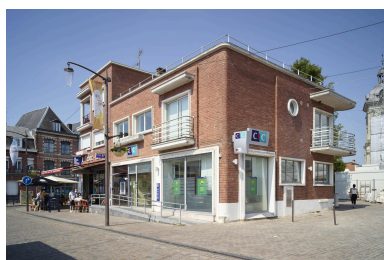
Extrémité sud/est du rang : façades sur la place du Général-Leclerc et sur la place de l'église. Vue orientée sud-est/nord-ouest. Phot. Pierre Thibaut IVR32_20235901003NUCA
