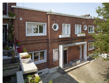
Vue cavalière des façades arrière du n°15 rue Fournier. Phot. Pierre Thibaut IVR32_20235901007NUCA
