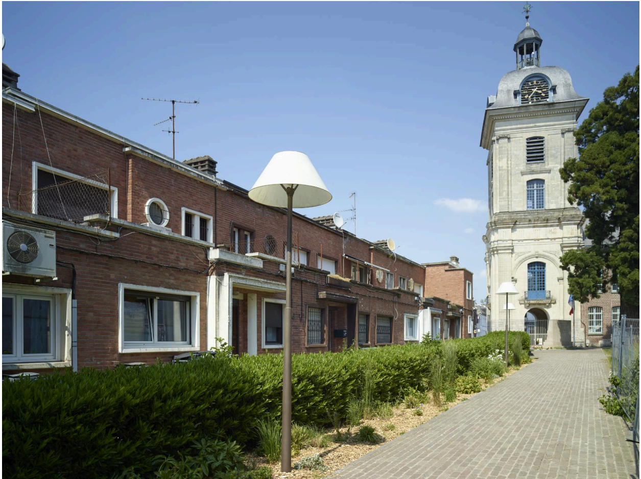
Vue générale des façades arrières orientée sud-ouest/nord-est.
