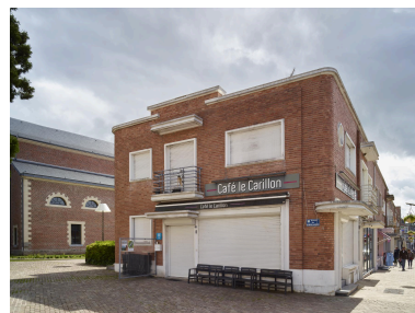
Extrémité nord/est du rang. Vue orientée nord-est/sud-ouest. Phot. Pierre Thibaut IVR32_20255900749NUCA
