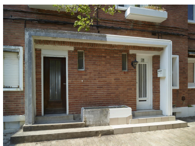
Détail de l'encadrement en béton des portes d'entrée côté place de l'Église (correspondant au n°15 rue Fournier). Phot. Pierre Thibaut IVR32_20235901004NUCA
