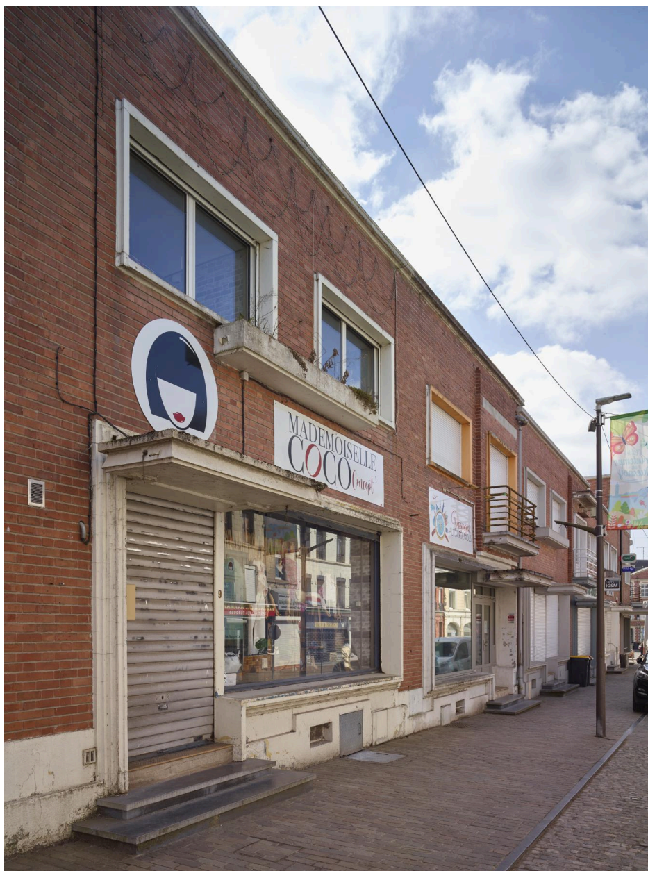
Vue d'ensemble du rang, côté façades avant. Vue orientée nord-est/sud-ouest.
