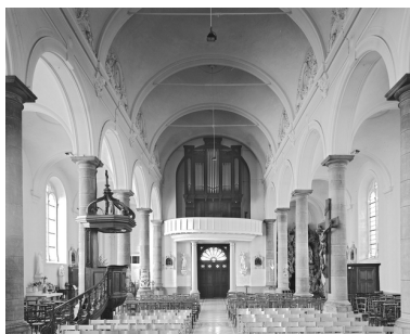
Vue générale intérieure vers l'entrée. Phot. Philippe Dapvril IVR31_20045900156V
