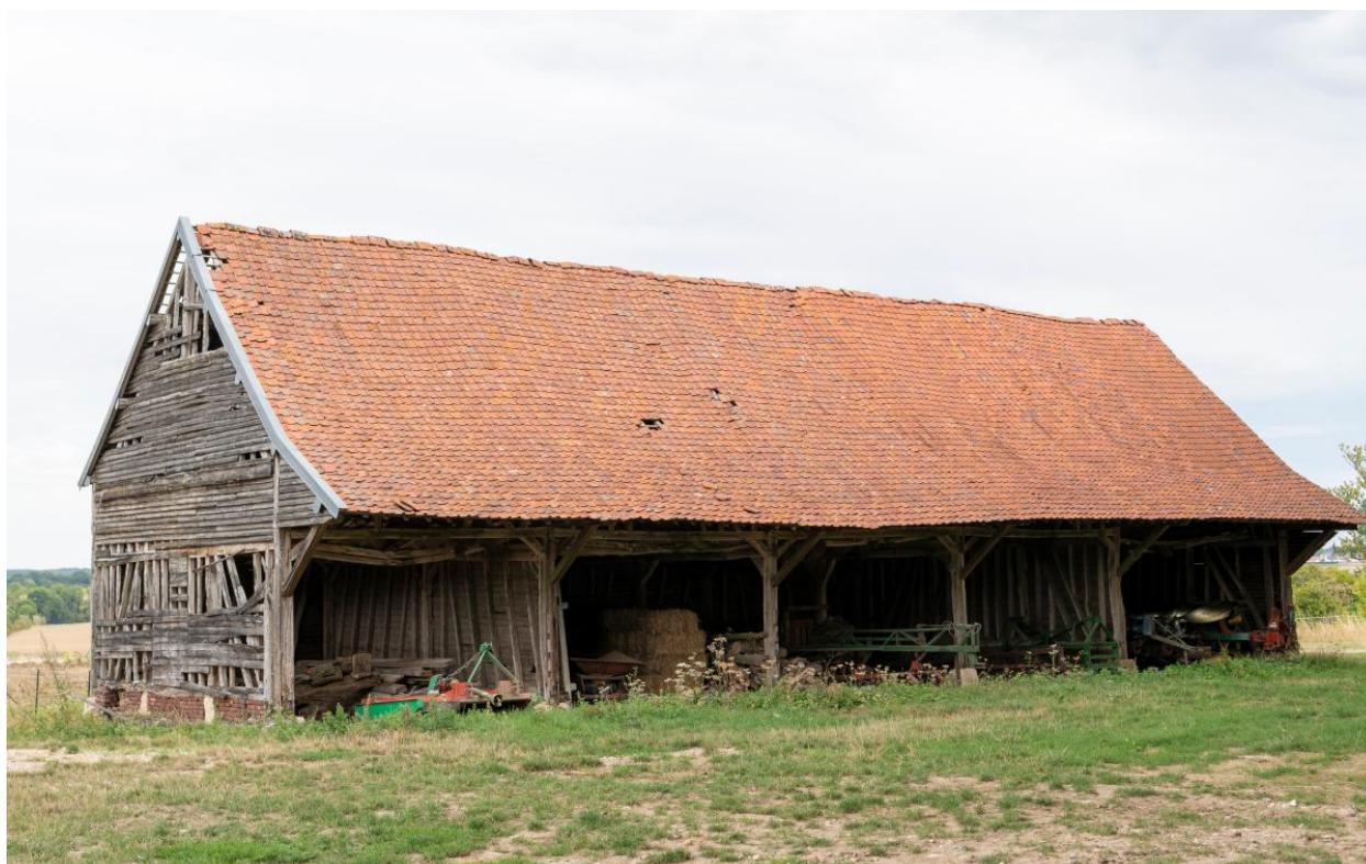
Ancien hangar agricole, vue depuis le sud-ouest.
