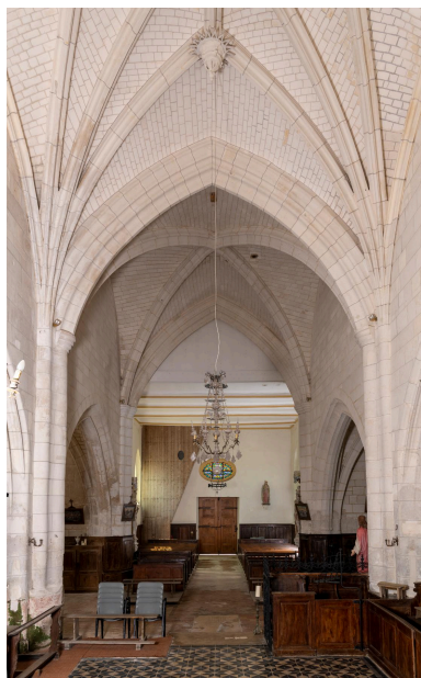
Vue générale vers la nef. Phot. Marc Kérignard IVR32_20236000784NUCA
