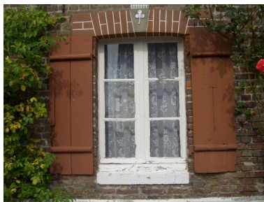
Vue détaillée d'un contrevent. Phot. Inès Guérin IVR22_20078005217NUCA
