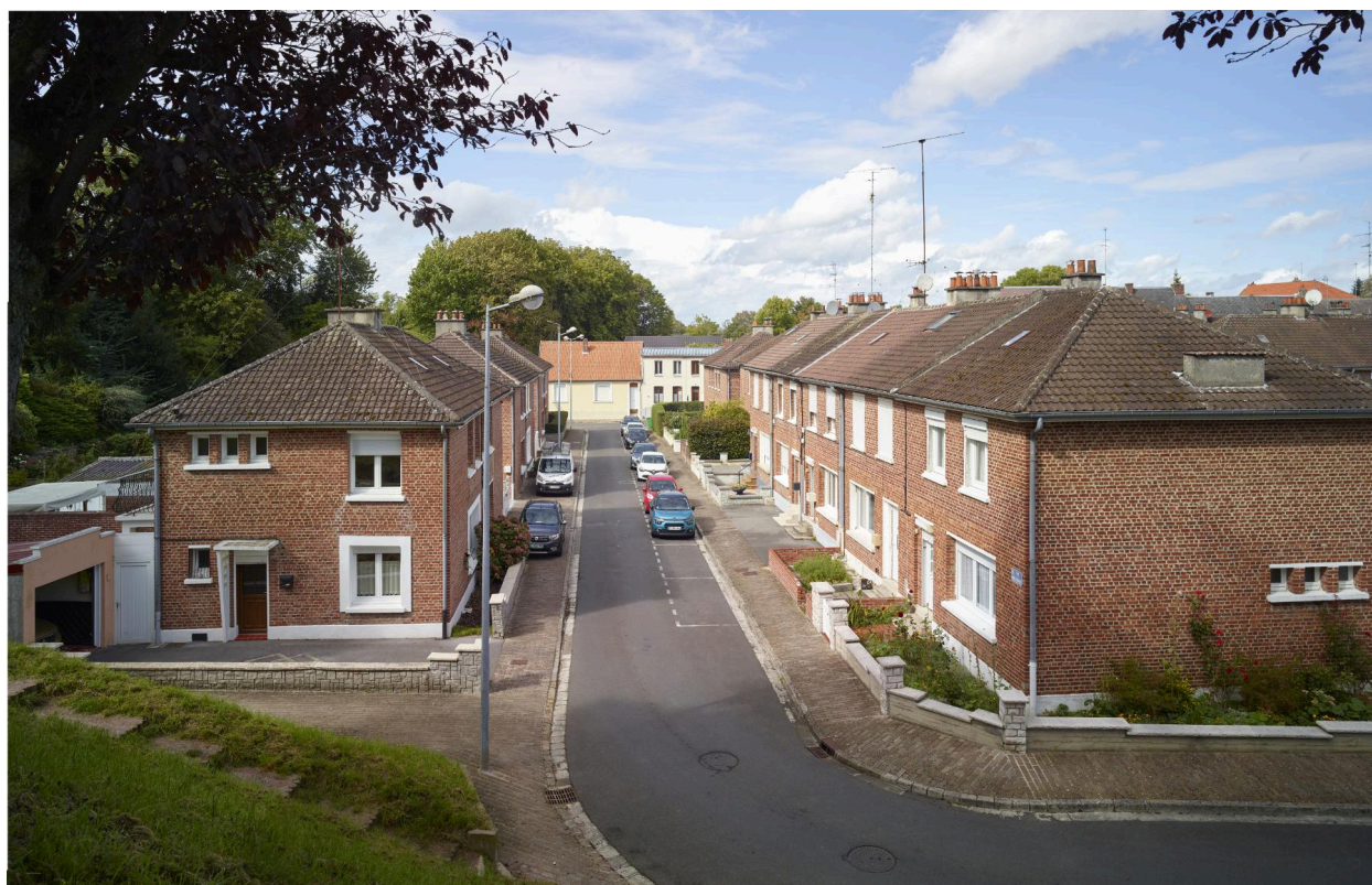
Vue générale de la rue depuis les remparts. Vue orientée sud-est/nord-ouest.
