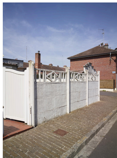
Détail de la clôture fermant le jardin entre la maison et le garage à l'arrière du n°2, avec un décor de béton moulé ajouré et des hauts de poteaux à ressaut typiques des années 1950. Phot. Pierre Thibaut IVR32_20255900536NUCA
