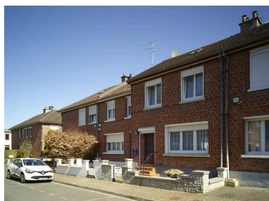
Détail des façades avant des n°10 et 12. Vue orientée sud-ouest/nord-est. Phot. Pierre Thibaut IVR32_20255900212NUCA
