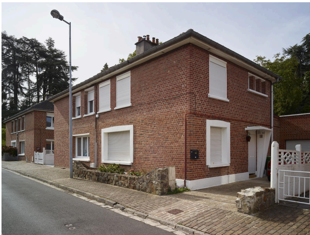
Détail des maisons jointives n° 5 et 7. Vue orientée nord-ouest/sud-est.
