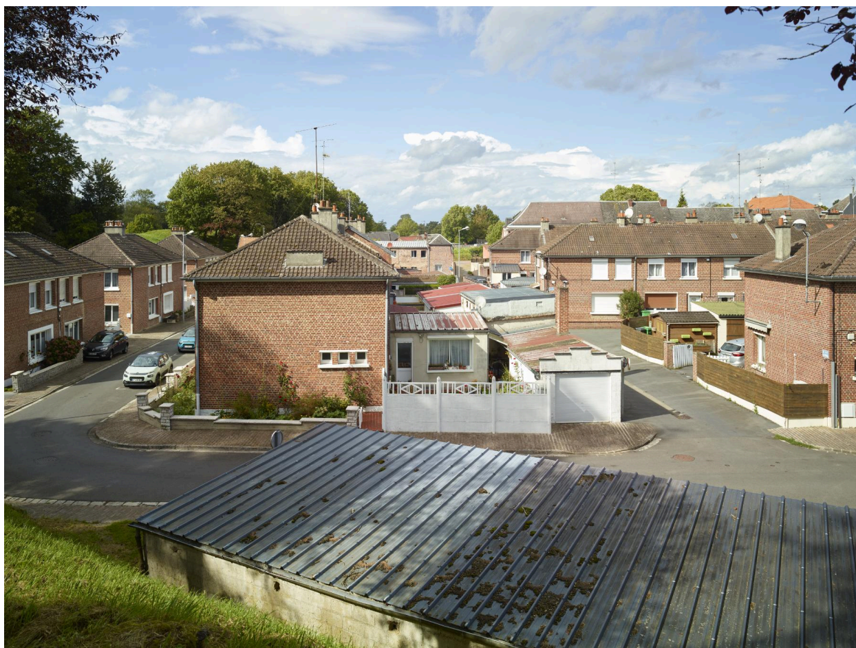
Façades côté impair, mur-pignon côté pair et ruelle desservant les garages. Vue depuis les remparts orientée sud-est/nord-ouest.
