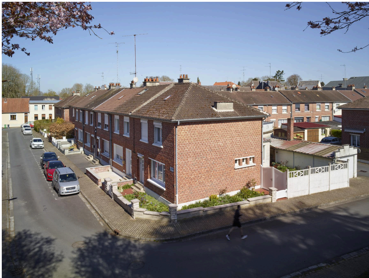
Vue générale du côté pair de la rue depuis les remparts. Vue orientée sud-est/nord-ouest.
