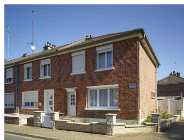
Détail des n°2 et 4. Phot. Pierre Thibaut IVR32_20255900211NUCA
