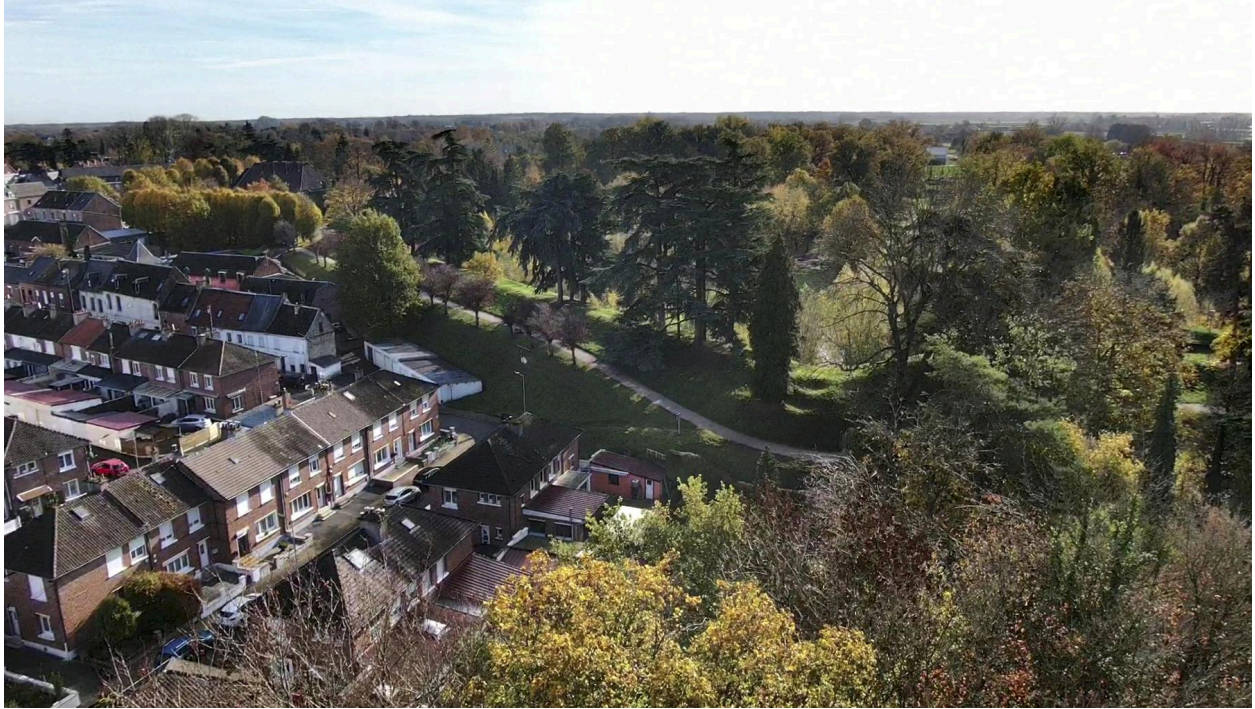
Vue aérienne de la rue Salengro orientée nord-ouest/sud-est, avec les terrées plantées à l'arrière-plan.
