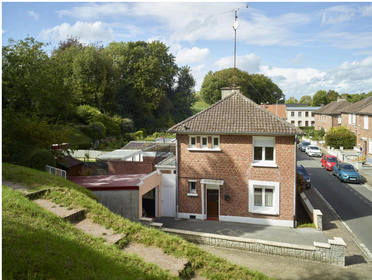
Détail des façades du n°1 et des n° 12 à 16. Vue depuis les remparts orientée sud-est/nord-ouest. Côté impair de la rue, les jardins viennent buter contre les terrées des remparts.
