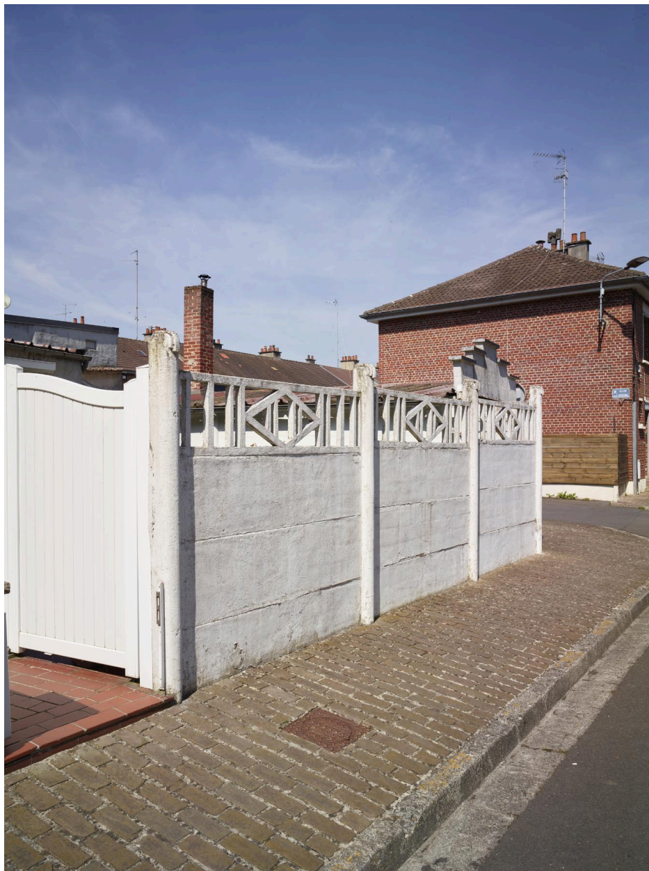
Détail de la clôture fermant le jardin entre la maison et le garage à l'arrière du n°2, avec un décor de béton moulé ajouré et des hauts de poteaux à ressaut typiques des années 1950.
