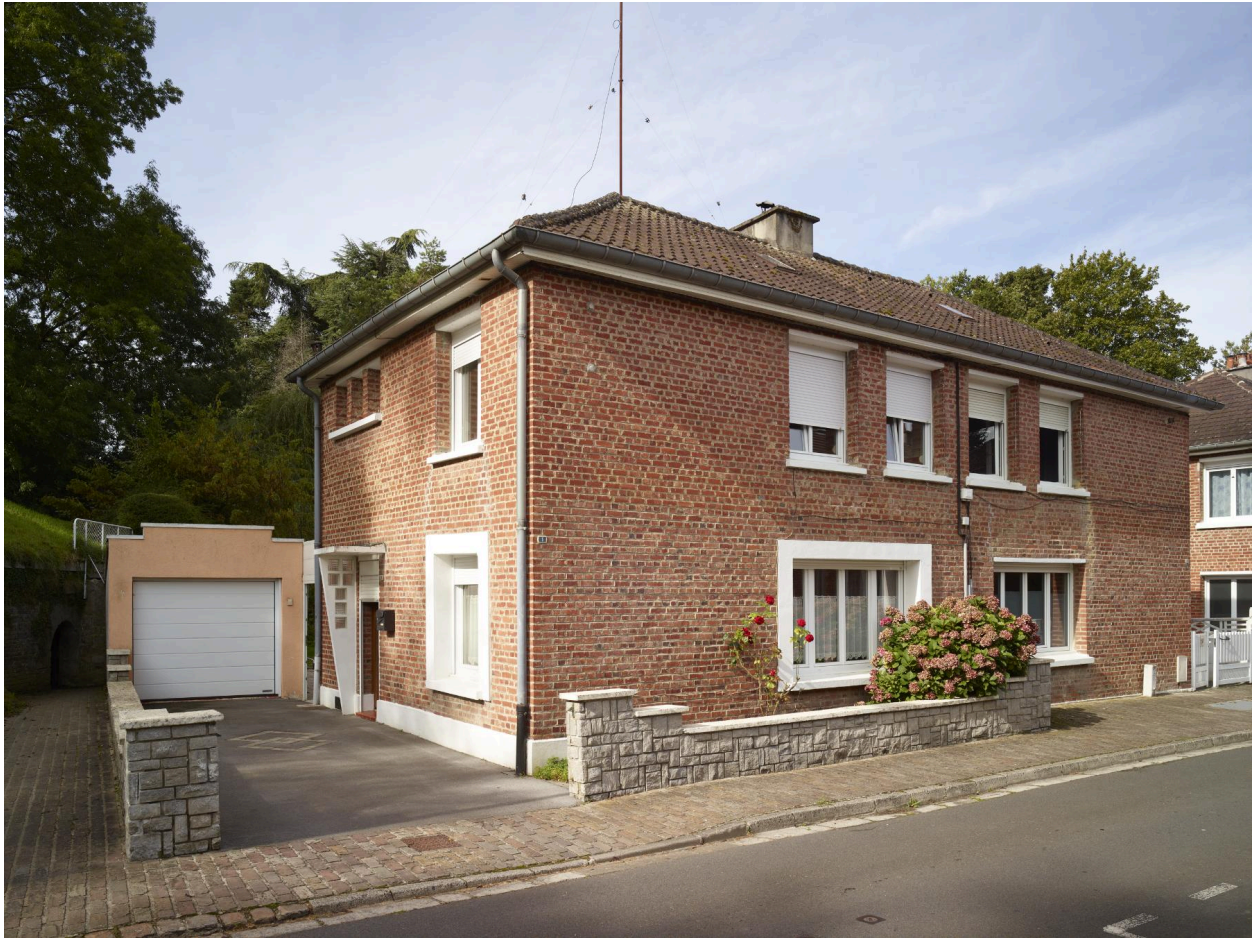
Détail des maisons jointives n° 1 et 3. Vue orientée sud-est/nord-ouest.
