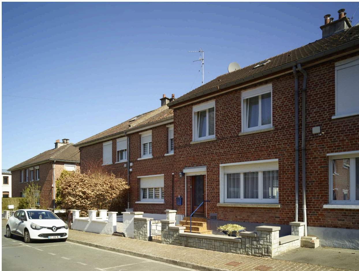
Détail des façades avant des n°10 et 12. Vue orientée sud-ouest/nord-est.
