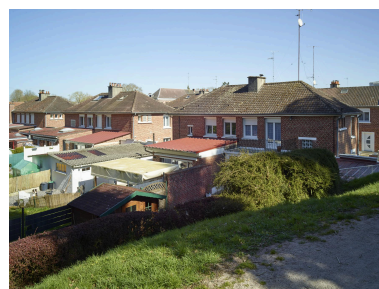
Vue de l'arrière du côté impair de la rue depuis les remparts. Vue orientée sud-est/nord-ouest. Phot. Pierre Thibaut IVR32_20255900210NUCA
