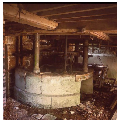
Intérieur du moulin, détail du beffroi et du mécanisme principal de transmission. Phot. Thierry Lefébure IVR22_20026000953NUCA
