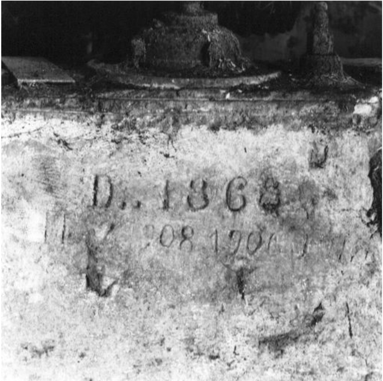
Détail de la date de 1868 gravée sur l'une des pierres du beffroi des transmissions.
