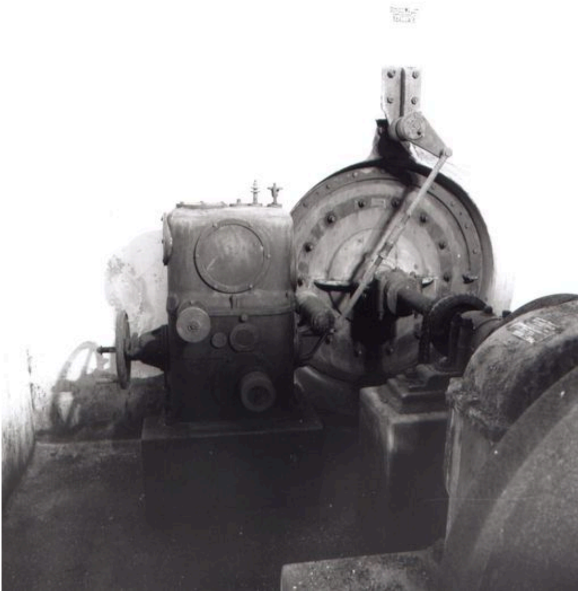
Détail de l'arbre de transmission horizontal et du régulateur.
