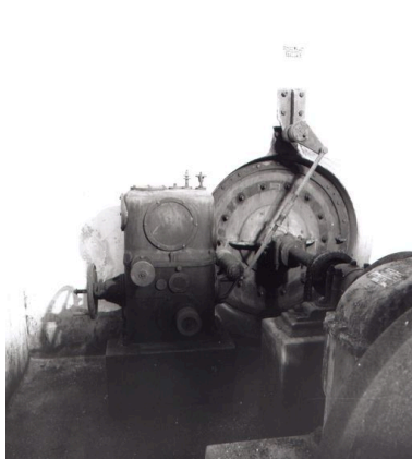
Détail de l'arbre de transmission horizontal et du régulateur. Phot. Thierry Lefébure IVR22_20026000763X
