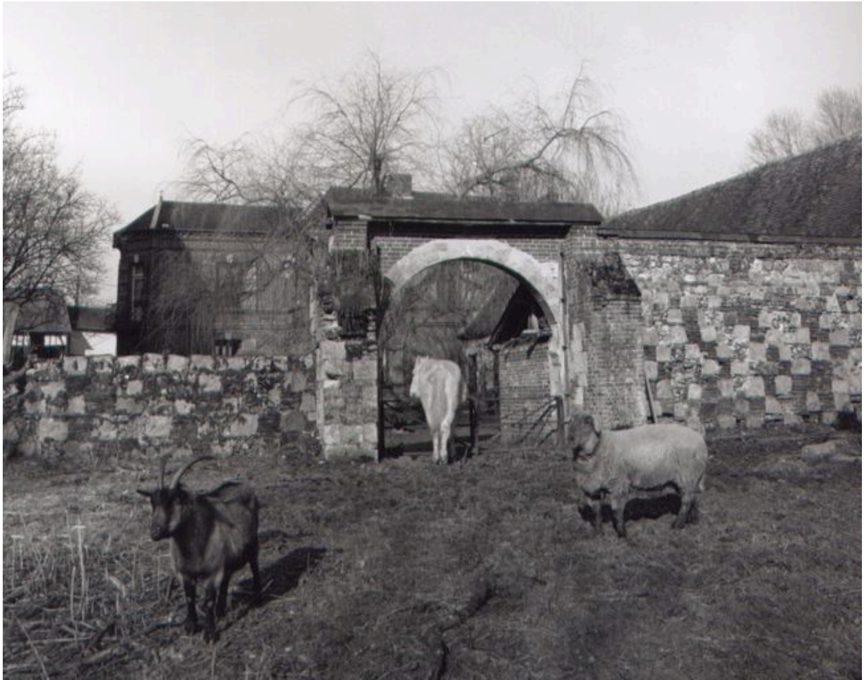
Le mur de clôture.
