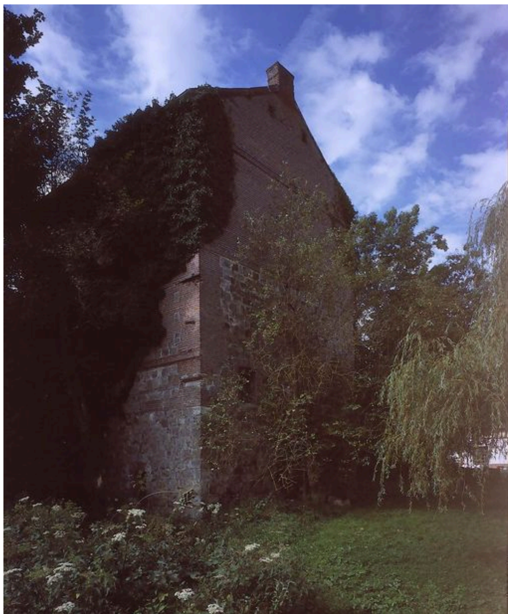
Pignon sur cour du moulin, vue d'ensemble.
