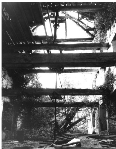
Élévation intérieure du moulin, du rez-de-chaussée aux combles. Phot. Thierry Lefébure IVR22_20026000751X
