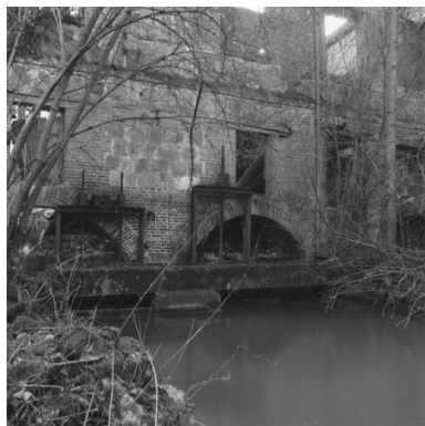
Les arches en plein cintre de la coulerie maçonnée du moulin Phot. Thierry Lefébure IVR22_20036000016X
