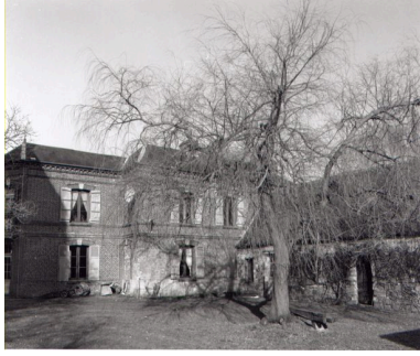
Vue d'ensemble sur cour de la ferme du moulin. Phot. Thierry Lefébure IVR22_20036000018X
