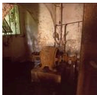
Alternateur Gramme couplé à la turbine, vue partielle. Phot. Thierry Lefébure IVR22_20026000955NUCA
