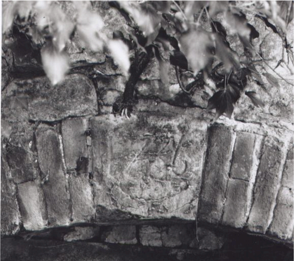
Détail la clef du linteau de la porte d'entrée du moulin portant la date de 1736.
