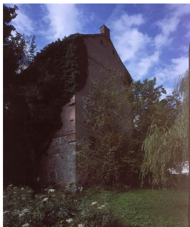
Pignon sur cour du moulin, vue d'ensemble. Phot. Thierry Lefébure IVR22_20026000951NUCA
