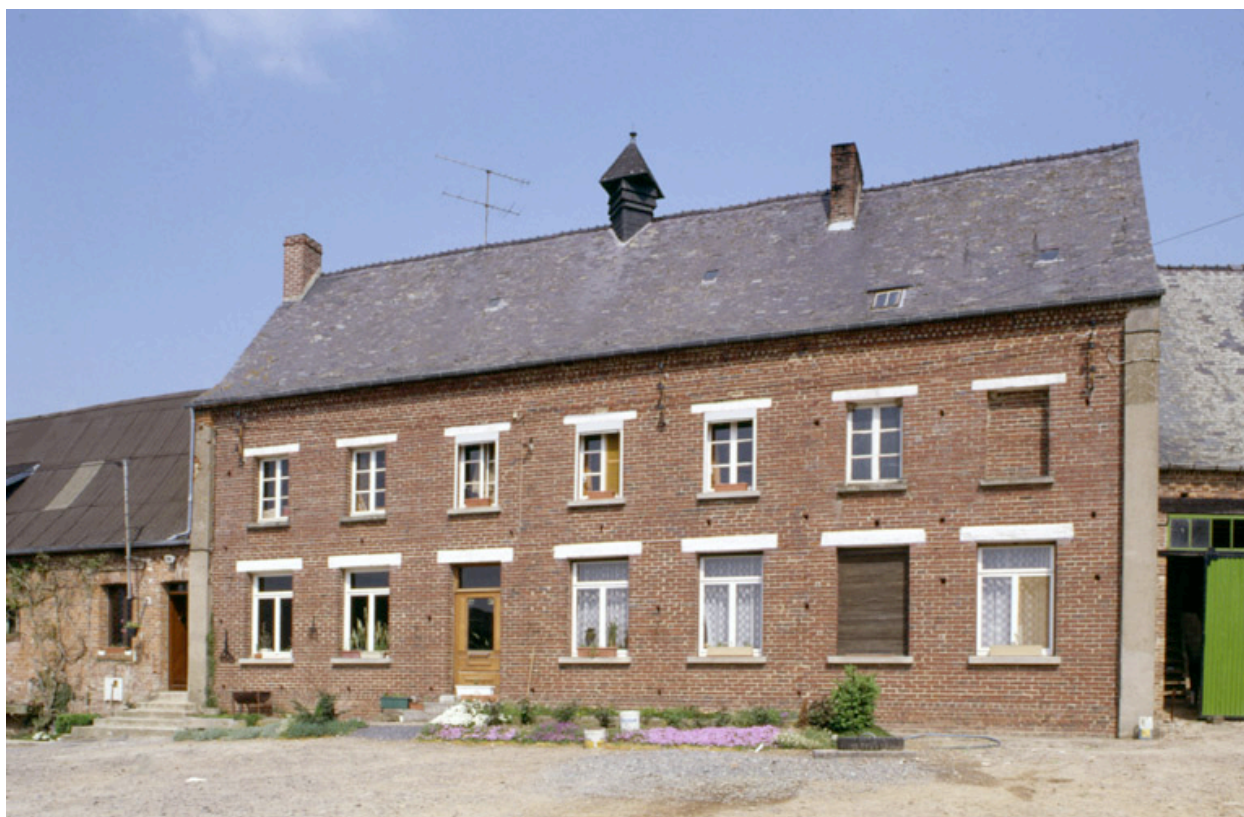
Vue générale de la façade du logis.
