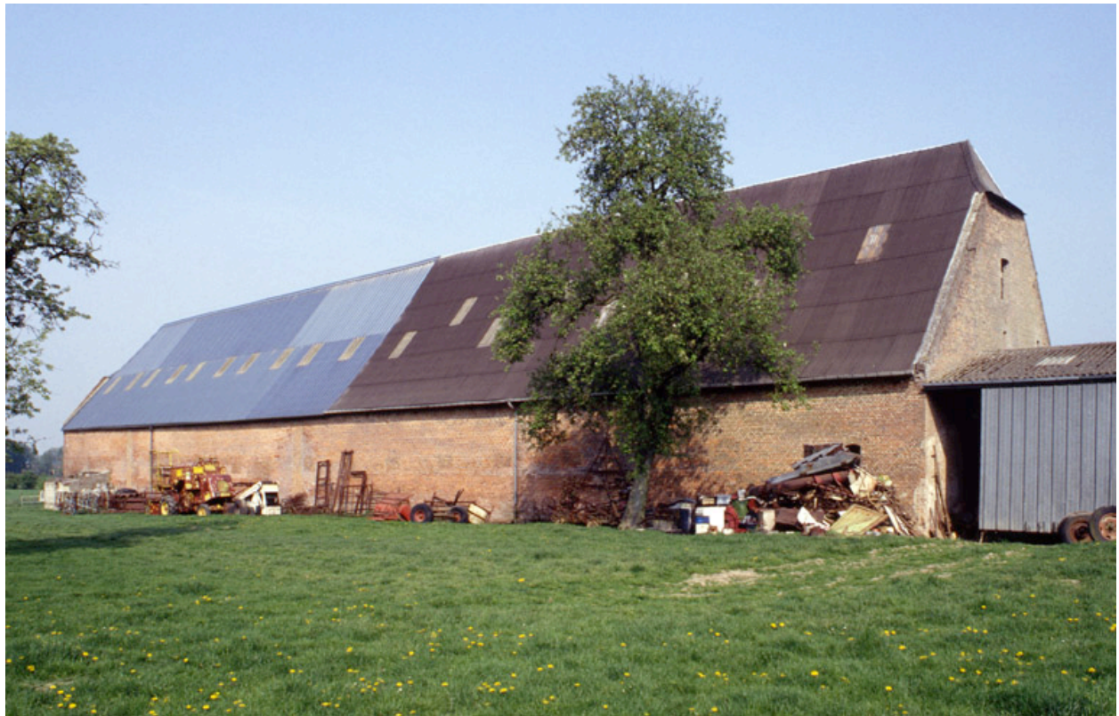
Vue d'ensemble sud-est de la grange.
