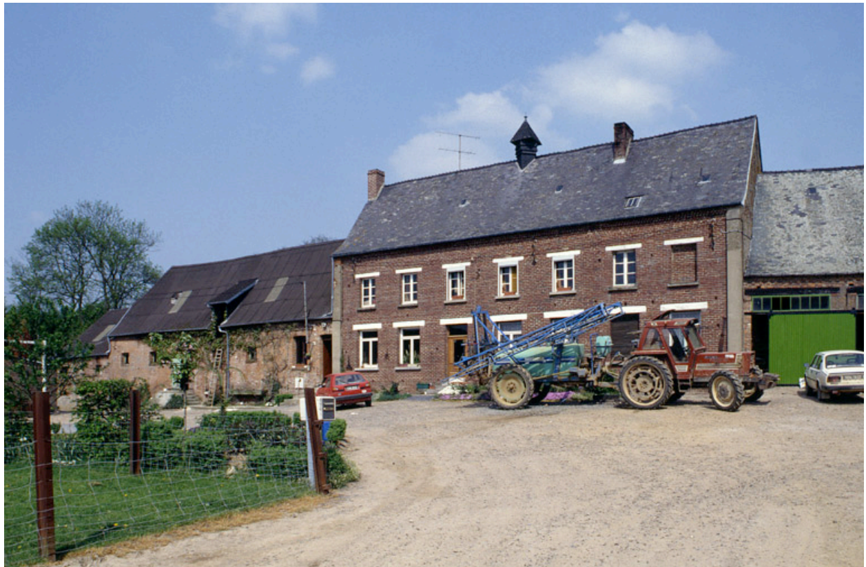
Vue d'ensemble du logis, depuis le sud-ouest.
