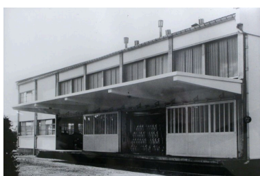
Façade sur cour de la laiterie vers 1960 (Coll. part.). Phot. Fournier Bertrand (reproduction) IVR22_20056001321NUCAB
