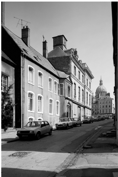
Vue d'angle sud-ouest. Phot. Éric Dessert, Phot. Jean-Michel Périn IVR31_19806202441X
