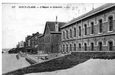
Elévation antérieure donnant sur la mer, vue en enfilade prise depuis le flanc sud de la terrasse aménagée au-devant des bâtiments. Carte postale, 1er quart du 20e siècle (coll. part.). Phot. Thibaut Pierre (reproduction) IVR31_20066200127NUCB
