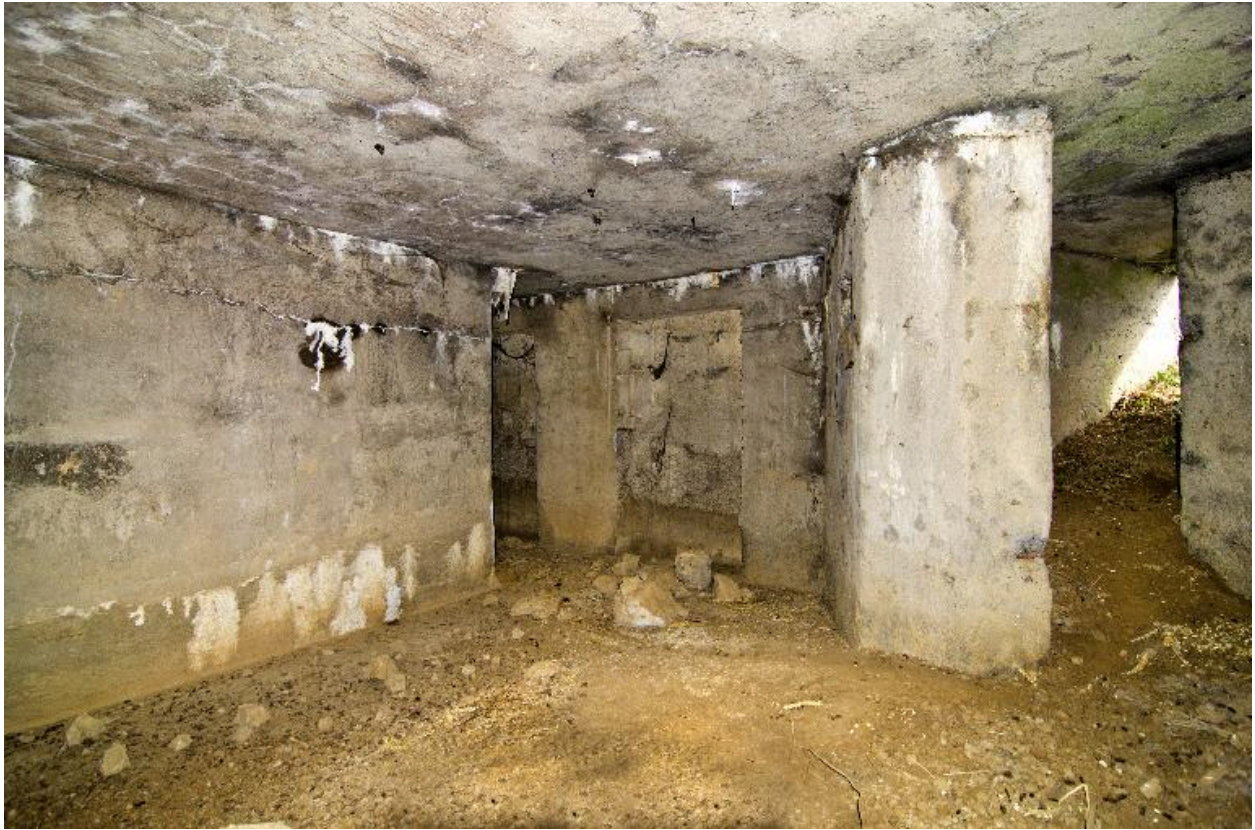
Entrée en chicane et salle sud (au très grand angulaire)
