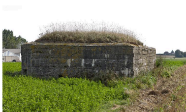
Vue latérale nord, vers le sud-ouest
