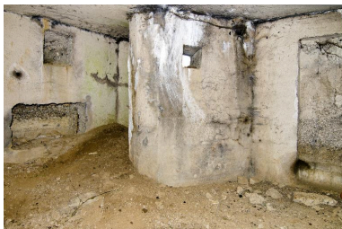
L'entrée en chicane, depuis la salle nord (au très grand angulaire) Phot. Jean-Marc Ramette IVR31_20145905038NUCA
