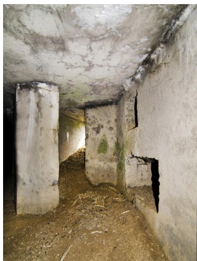
A droite le créneau de fusillade et la niche à munitions.
