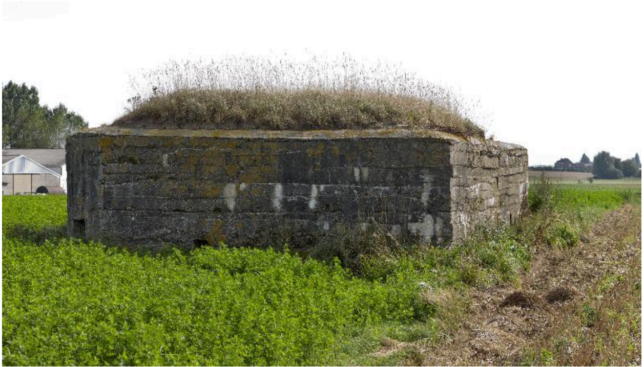
Vue latérale nord, vers le sud-ouest
