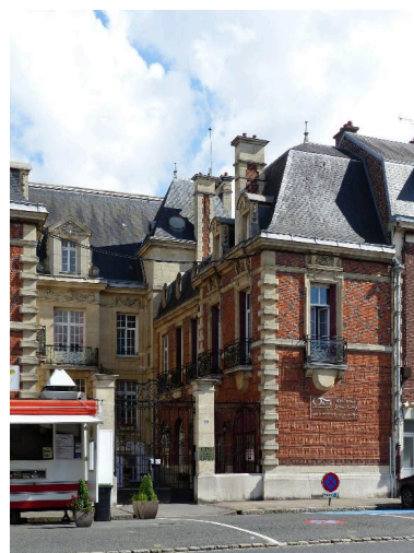
Vue de l'aile sud. Phot. Isabelle Barbedor IVR32_20178005255NUCA
