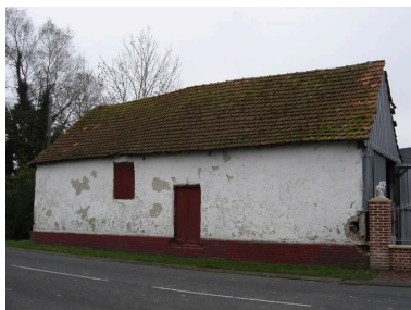
Vue de la grange. Phot. Inès Guérin IVR22_20068005859NUCA
