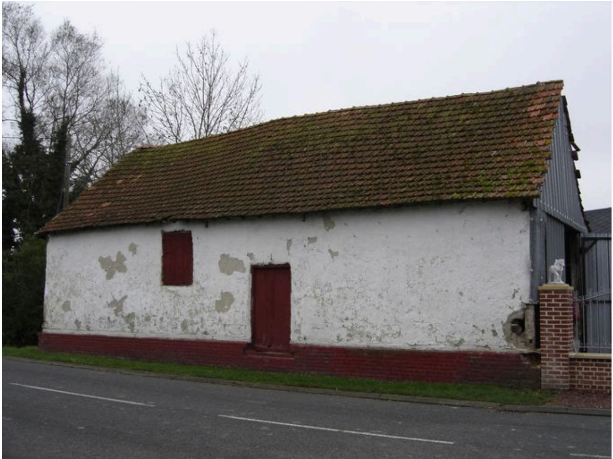
Vue de la grange.
