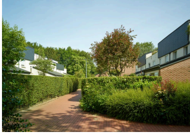
Chemin piétonnier, à l'arrière des jardins, parcourant l'ilot du nord au sud. Phot. Pierre Thibaut IVR32_20185900674NUCA
