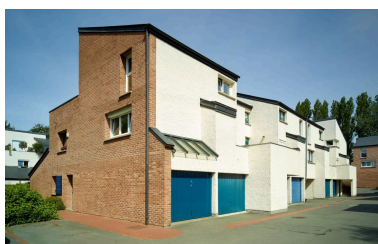
L'allée des Charmettes vue depuis l'entrée de l'îlot. Elle dessert une première bande de logements (n°42-56). Phot. Pierre Thibaut IVR32_20185900666NUCA
