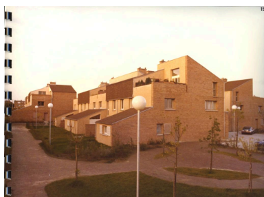
Vue depuis la placette marquant l'entrée de la Châtellenie. Photographie, 1978. On note le parement initial, intégralement en brique (AC Villeneuve d'Ascq ; 16W3). Repro. Pierre Thibaut IVR32_20215900445NUCA
