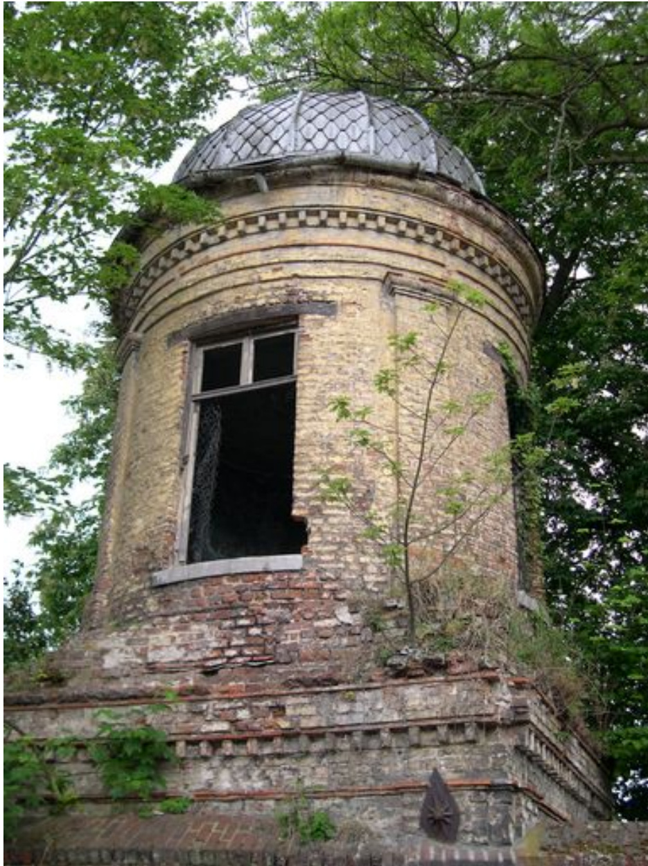
Fabrique de jardin, vue depuis la rue Molière.
