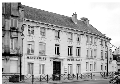
Vue générale (état en 2000). Phot. Pierre Thibaut IVR31_20005902399X
