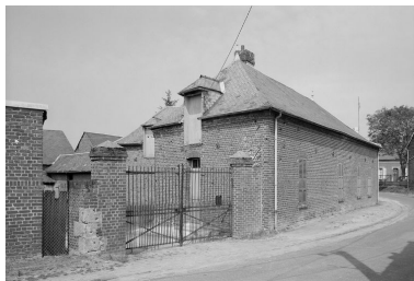
Logis. Elévation sur rue. Phot. Jean-Michel Perrin IVR22_19856000859X
