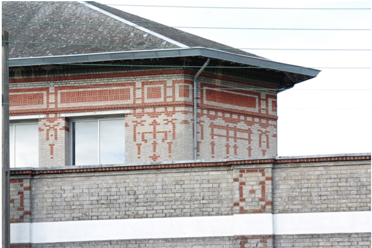
Détail de la façade, boulevard Victor-Hugo.
