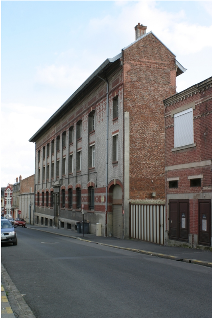
Anciens bureaux et entrepôts (maison de commerce) du tissage Léon, rue du Général Foy. A droite, entrée de la cour de l'usine.
