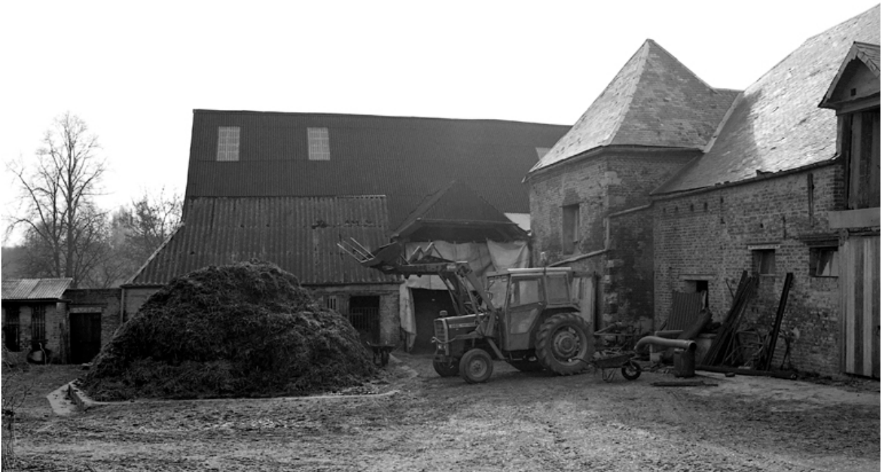
Grange et étable à l'ouest de la cour.
