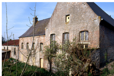
Elévations externes du logis prioral. Phot. Christiane Riboulleau IVR22_19930201140ZA
