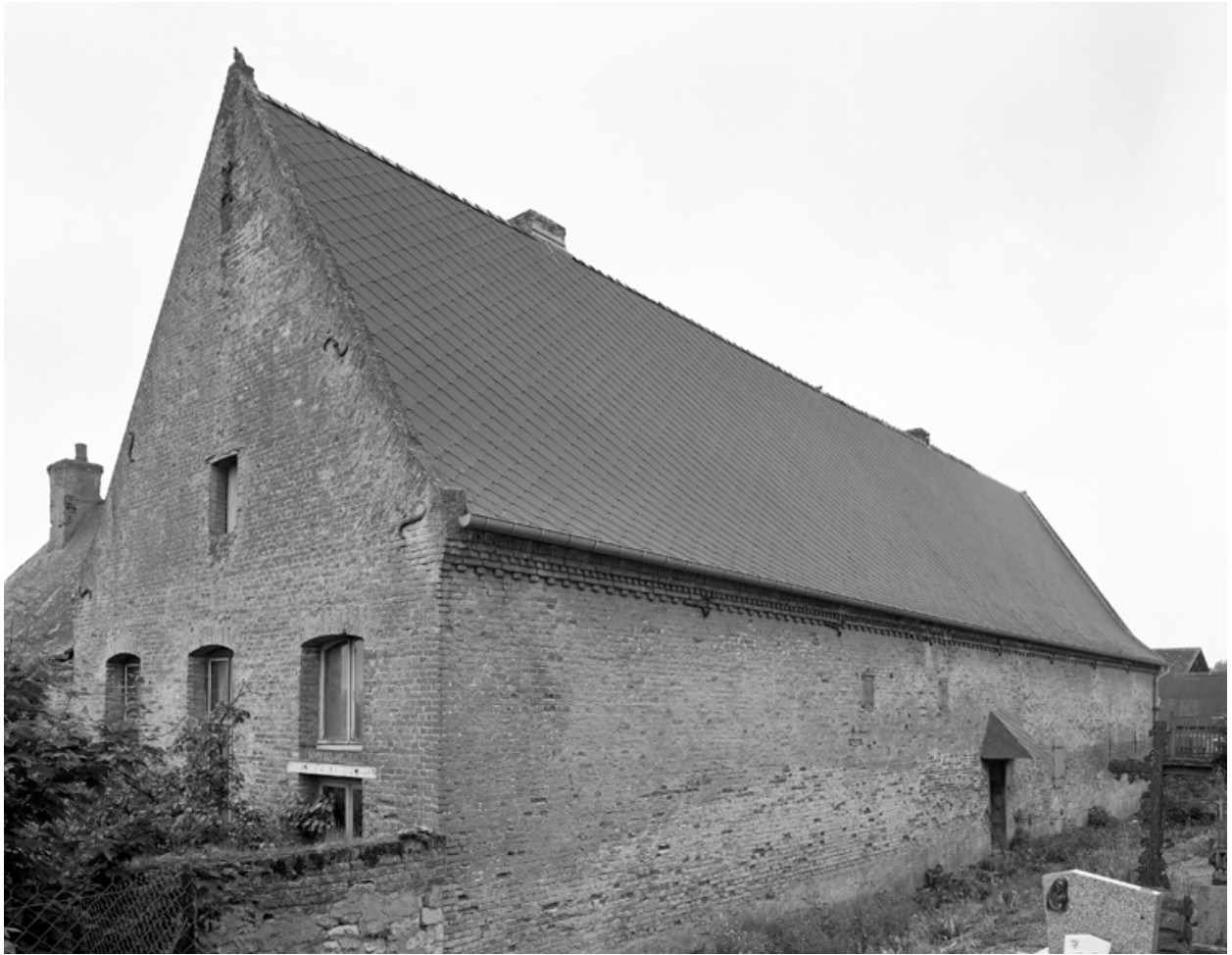
Logis prioral depuis le nord-est.
