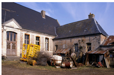
Vue partielle du logis prioral et de son extension en brique. Phot. Christiane Riboulleau IVR22_19960200169ZA
