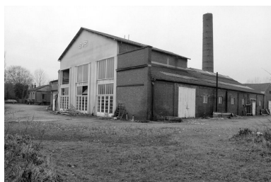
Chaudferie et cheminée, élévation sud est. Phot. Benoît Dufournier IVR22_19878000484Z
