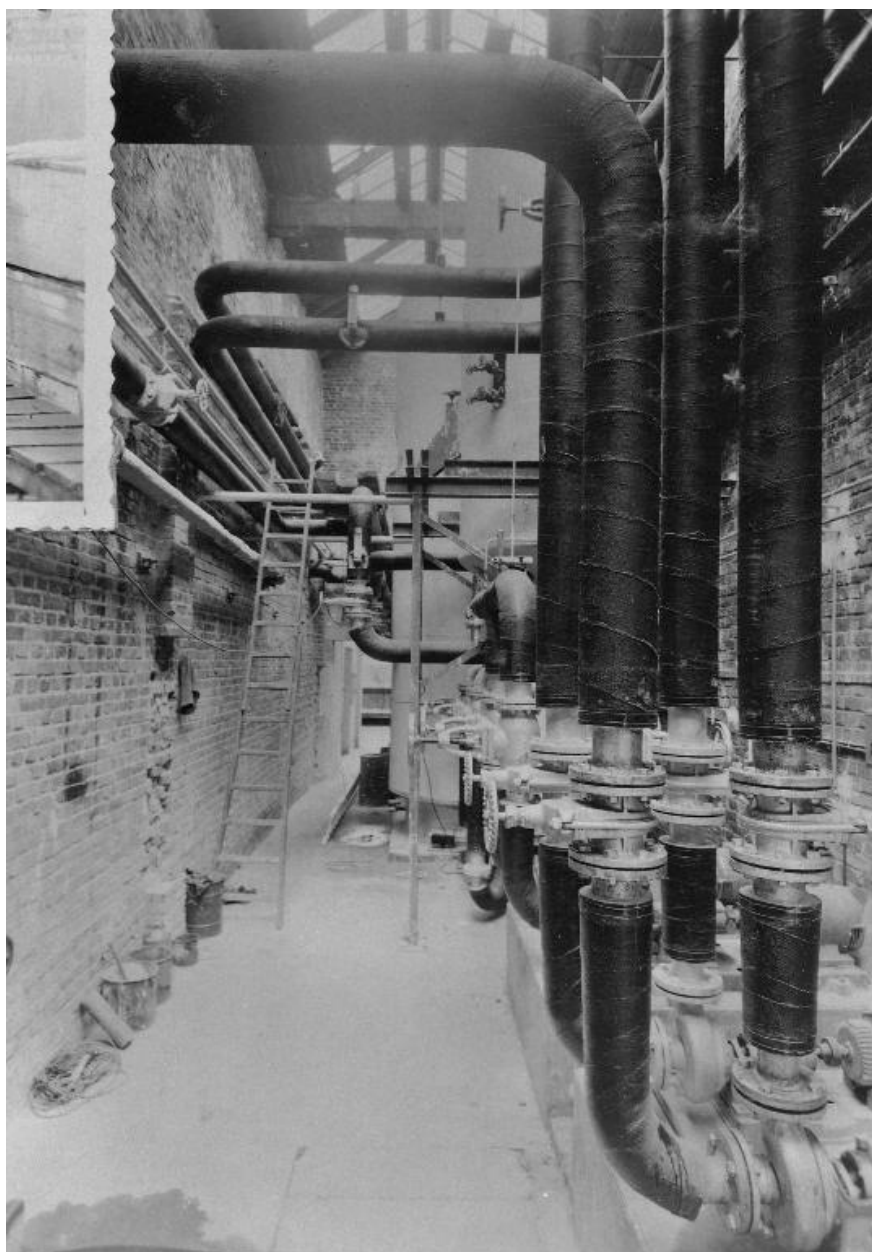
Tuyaux d'épuration, juillet 1953 (coll. part.).
