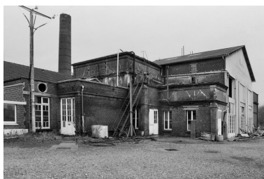
La chaudferie et la cheminée vues du sud-est. Phot. Benoît Dufournier IVR22_19878000486Z
