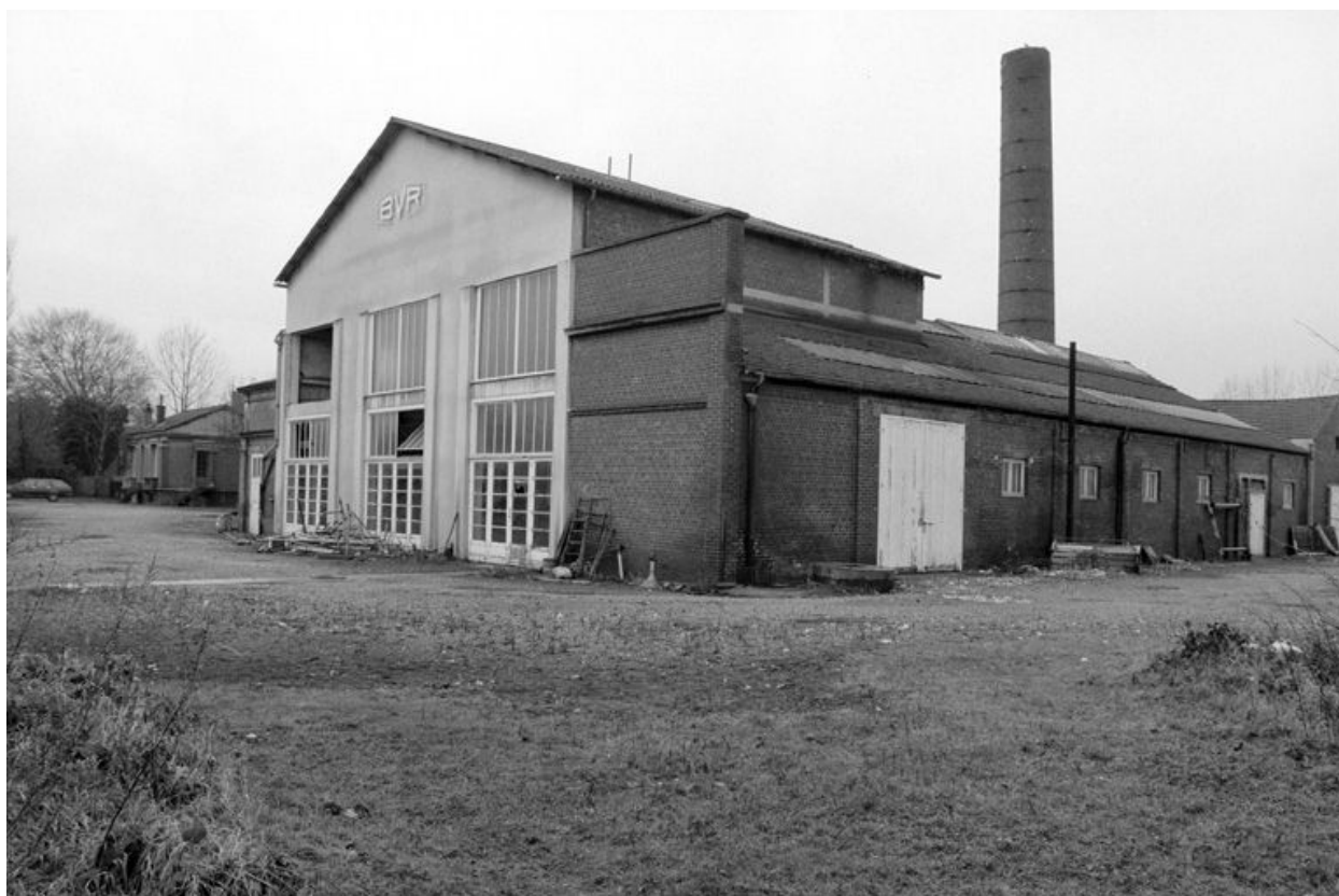
Chaufferie et cheminée, élévation sud est.
