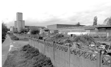
Vue des ateliers en 1992. Phot. Benoît Dufournier IVR22_19926000217Z
