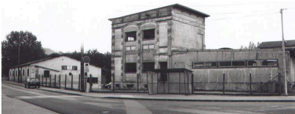
Vue d'ensemble sur rue.
