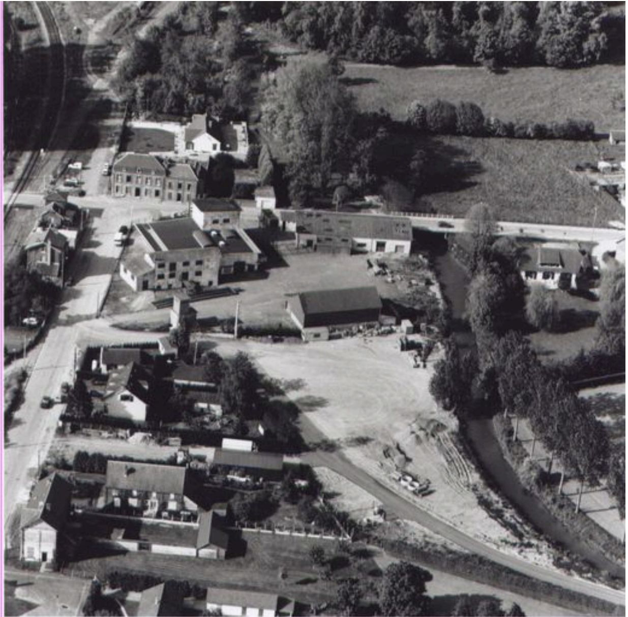
Vue aérienne de l'usine en 1994.
