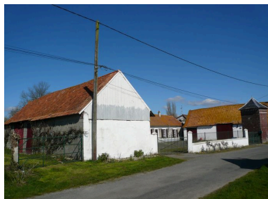
Vue d'ensemble. Phot. Inès Guérin IVR22_20078005745NUCA
