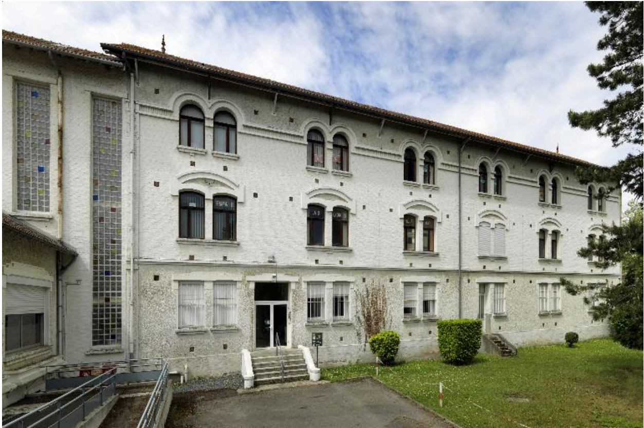
Le bâtiment des chambres et la cage d'escalier (à gauche sur l'image). Façade est sur la cour-jardin.
