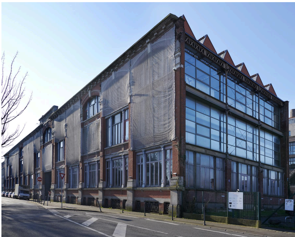
Vue générale, trois quarts nord-ouest.
