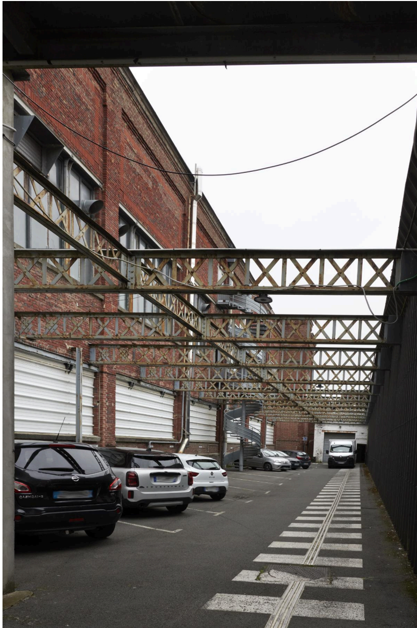
Bâtiment donnant rue des Arts, vue de l'arrière.
