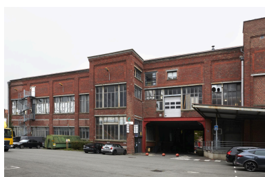
Bâtiment donnant rue des Arts, vue de l'arrière sur cour. Phot. Delphine Volto Jourdan IVR32_20265900101NUCA
