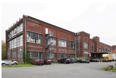
Bâtiment donnant rue des Arts, vue générale de l'arrière sur cour. Phot. Delphine Volto Jourdan IVR32_20265900103NUCA
