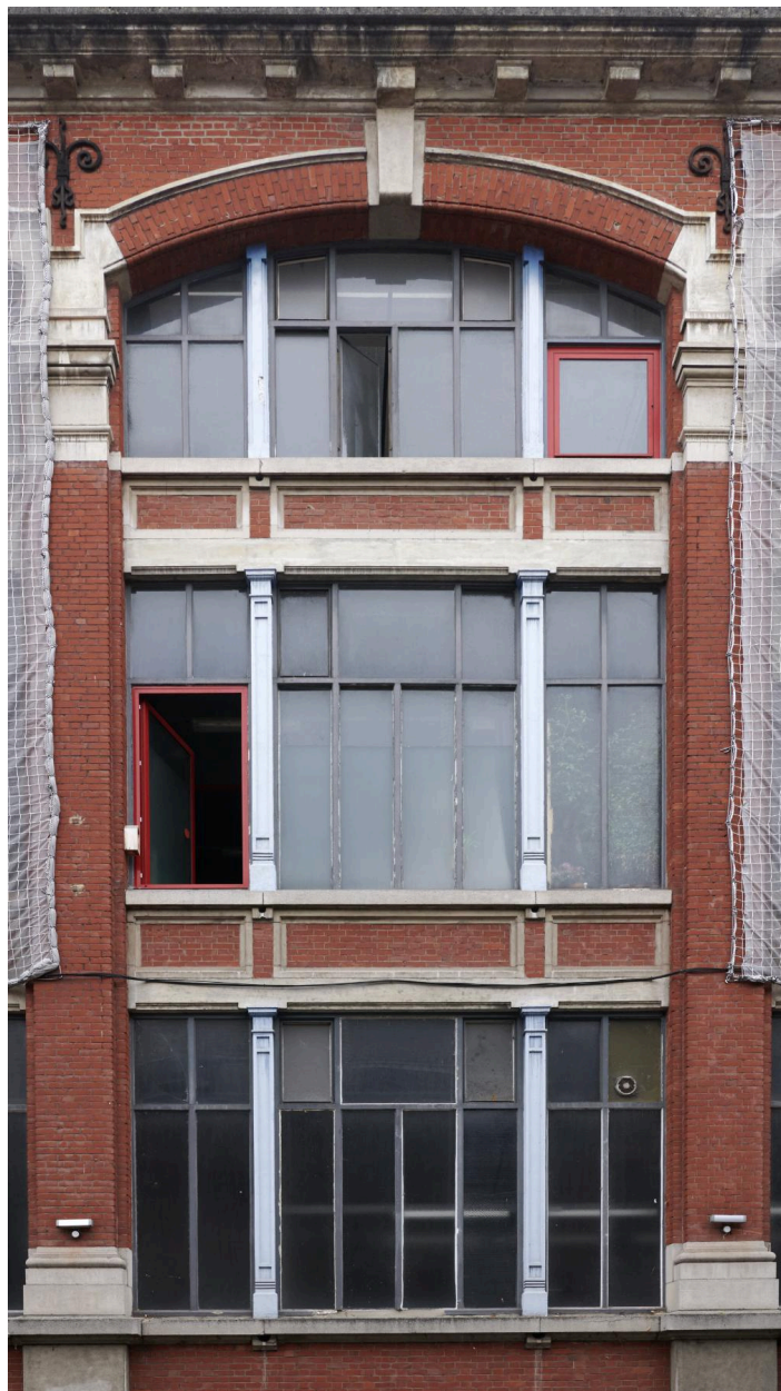
Bâtiment donnant rue des Arts, façade Art déco, fenêtres rectangulaires en anse de panier, pilastres et colonnes.
